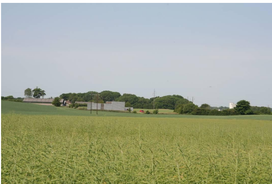
Figur 7: Mjang Dam vandværk
