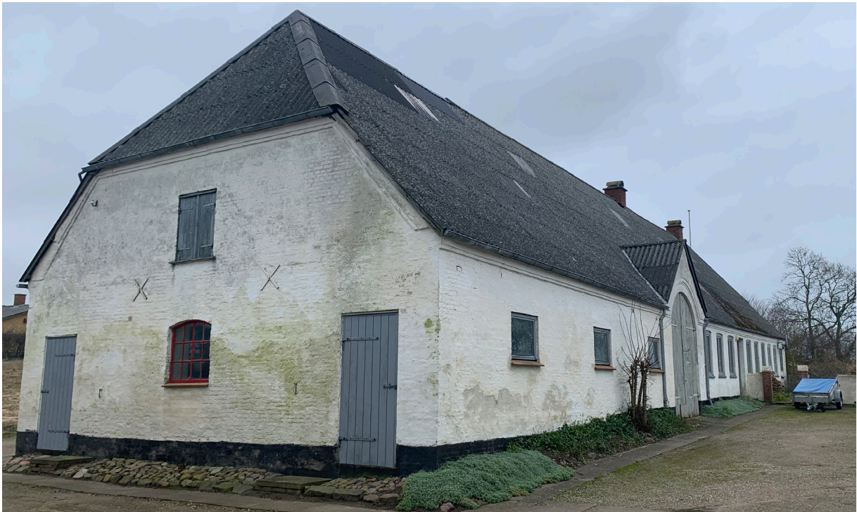
Ladebygningens vestlige gavl.
