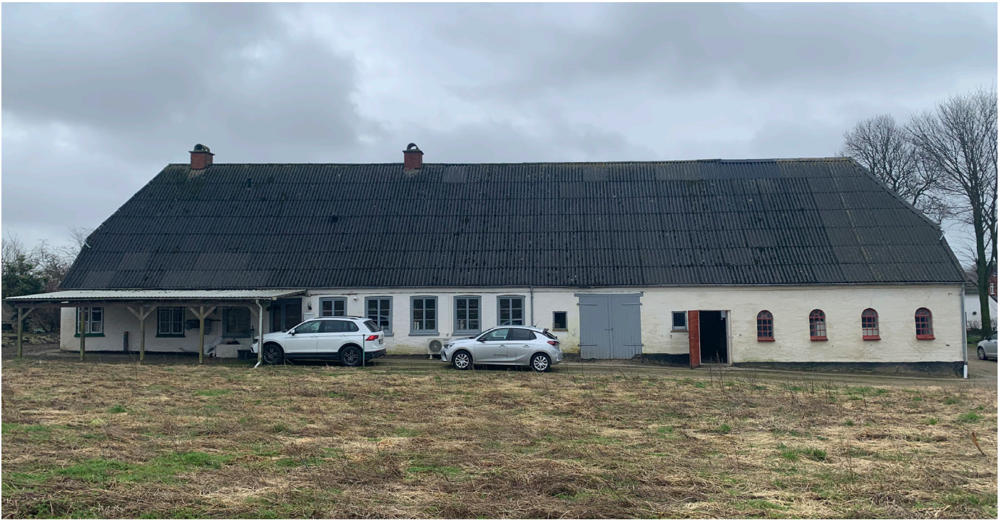
Hovedbygningen set fra nord.
