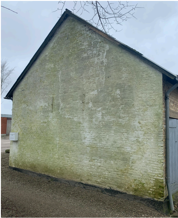
Ladebygningens sydlige gavl.
