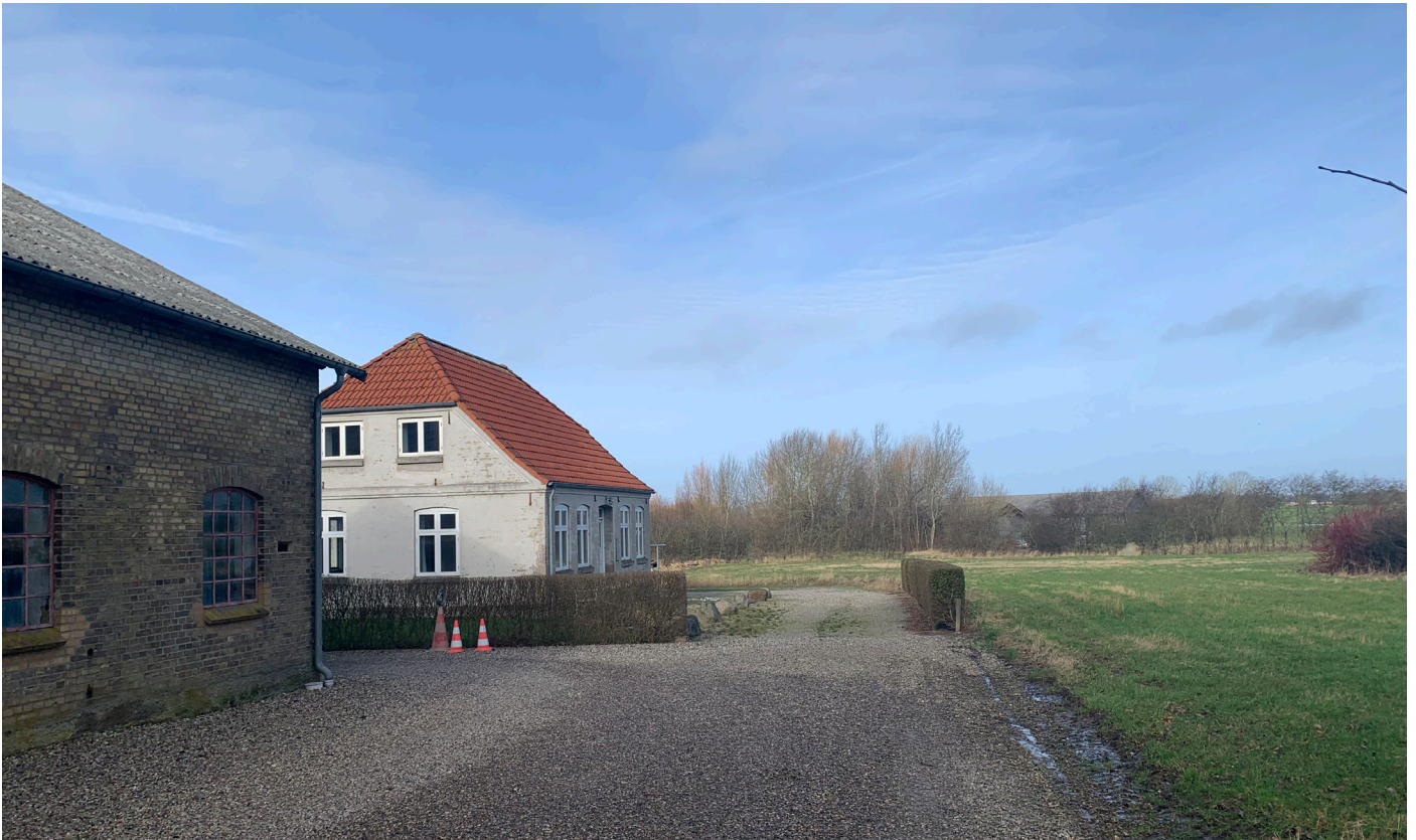
Den nedrivningsansøgte ejendom set fra Gammel Fabriksvej.
