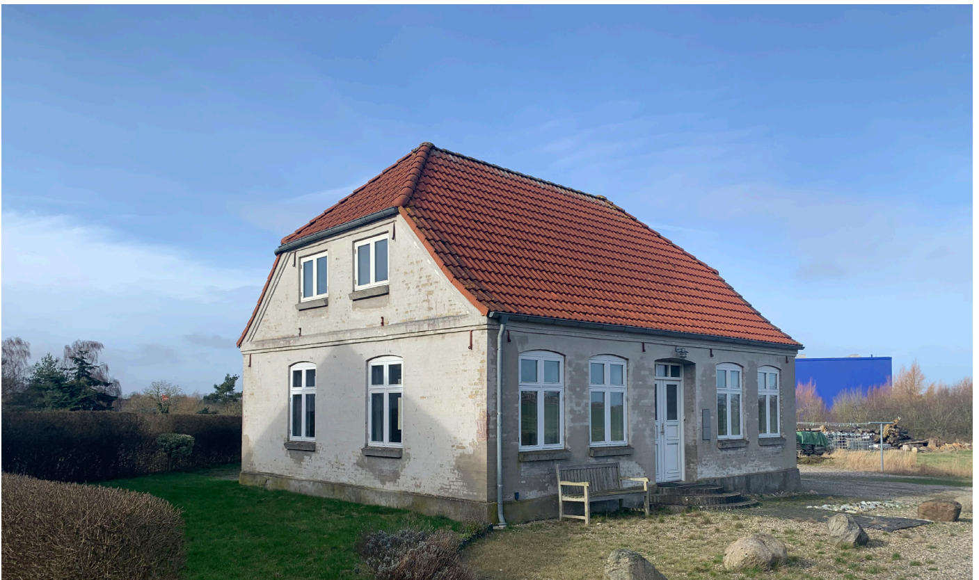
Den nedrivningsansøgte ejendom sydlige gavl og østfacade.
