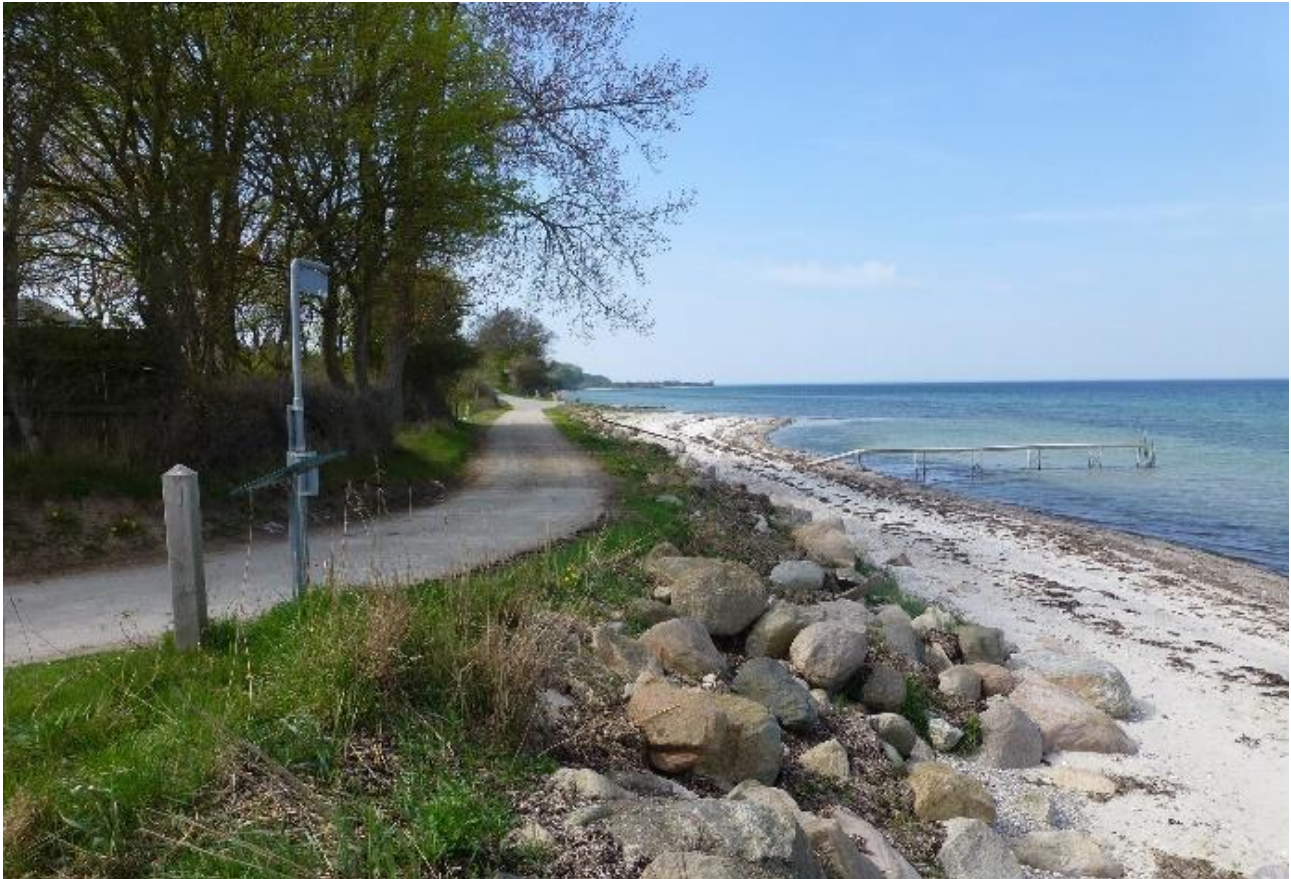
Figur 1. Foto af Ærvej, på den sydøstlige del af strækningen, hvor vejen er mest kystnær. Her ses, at der i dag forekommer en vis kystbeskyttelse i form af store sten.
