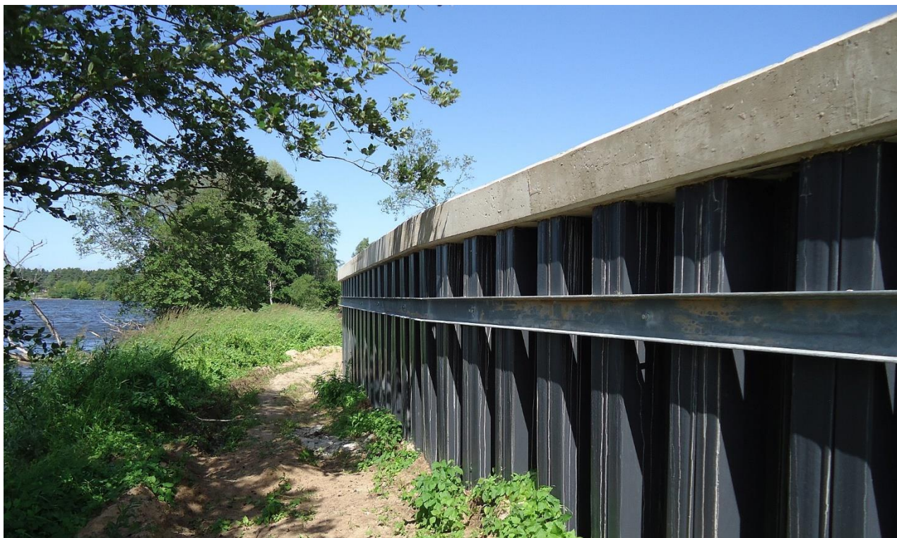
Figur 8: Koncept, hvor der er anvendt spuns som kystbeskyttelse 2 . Bemærk, der kan opnås forskellige udtryk af denne løsning afhængig af evt. beklædning og topafslutning mv.
