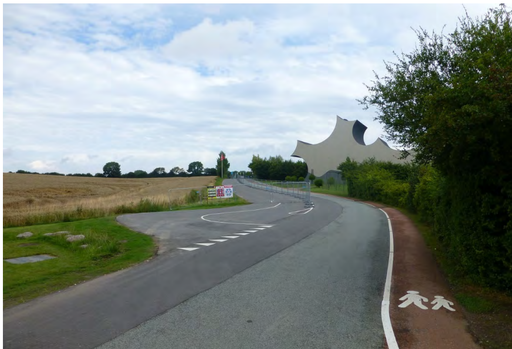
Figur 16-26. Anlagt anlægsvej på vestsiden af Mads Patent Vej. Anlægsvejen er anlagt tidligt til brug for en udvidelse af p-pladserne ved Universe Science Park.
