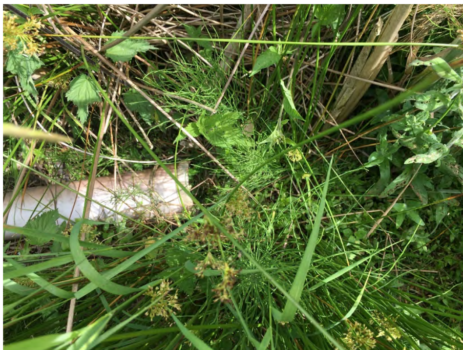
Figur 12-1. Foto af drænudløb til vandhul nr. 23.
