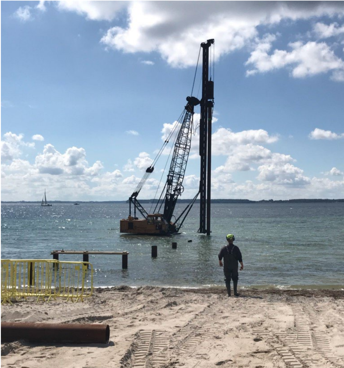
Figur 3-4. Ramning af pæle på lavt vand indtil 1 m vanddybde.
