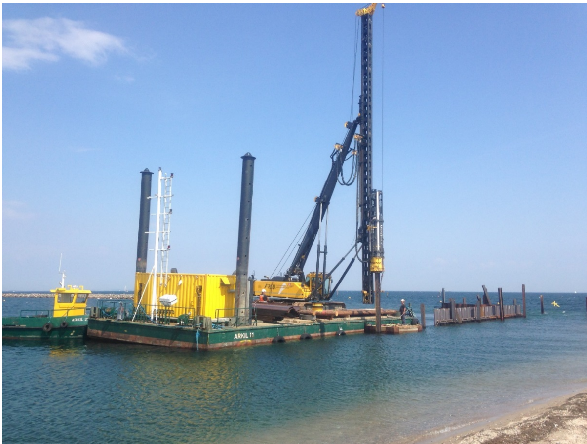
Figur 3-5. Ramning af pæle fra pram på vanddybder over ca. 1 m.
