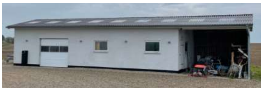
Foto fra besigtigelse den 29.09.2023.
