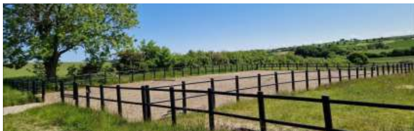
Foto fra besigtigelse den 29.09.2023.
