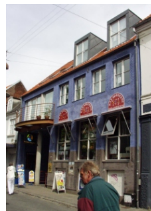
Mindre heldig indpasning. Bygningens elementer og farve afviger fra det eksisterende.
