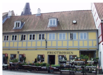
Diskret og tilpasset renovering.
