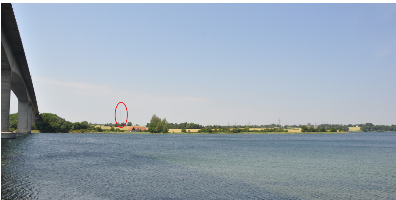
Billede fra den alske kyst ved Alssundbroen, hvor lokalplanområdet ligger i baggrunden. Man ser svagt den eksisterende antenne på ca 43 meter, der er placeret på Løntoft 3 i lokalplanområdet.
