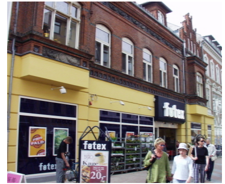
Voldsom skiltning og manglende underetage....
