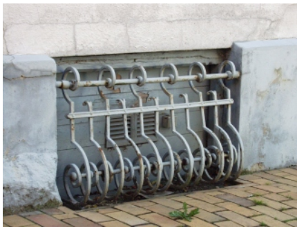
Smedjærngitter foran kælderåbning.
