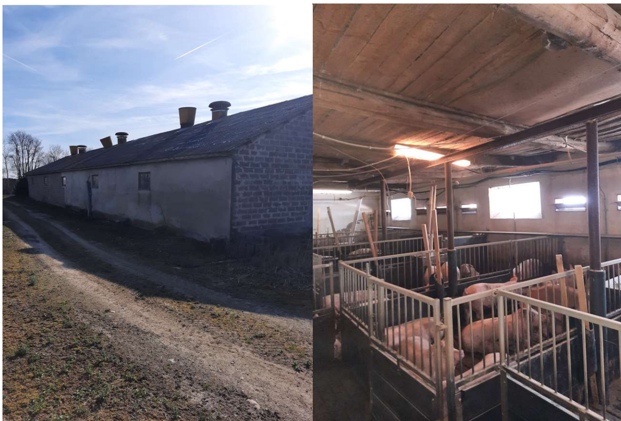
Figur 15: Billeder af de eksisterende bygninger
