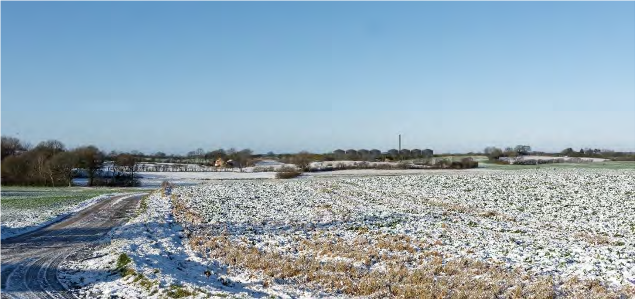
Figur 9.10: Standpunkt 5. Set fra Limbækvej sydøst for anlægget (ved Engskov), kun toppen af de høje tanke samt skorsten, er synlig i landskabsbilledet. På grund af tankenes mørke farve afskiller de sig ikke væsentligt fra den beplantning, de står bag ved.
