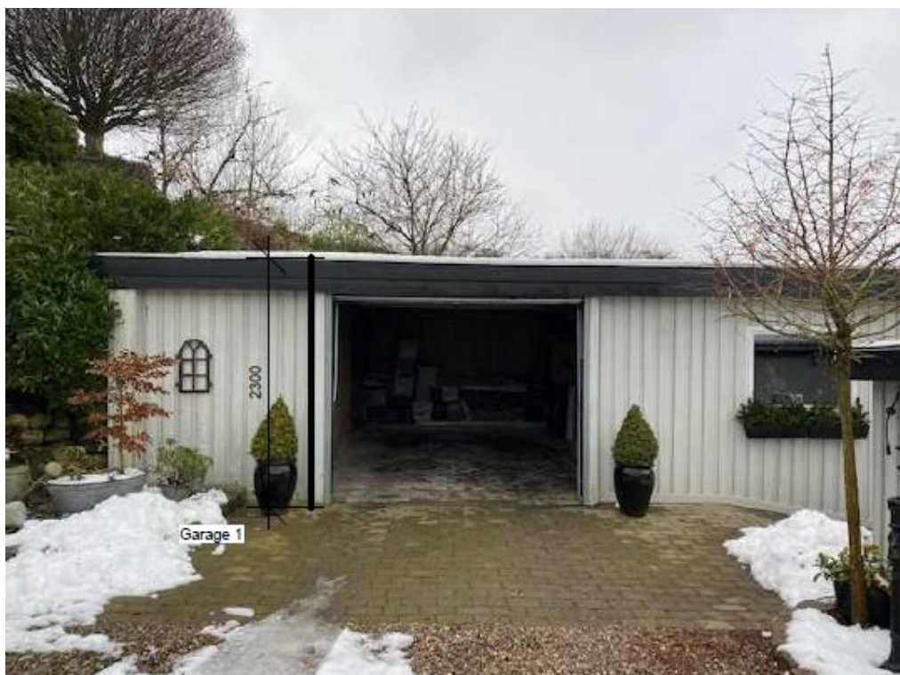
Garage på 67 m 2
