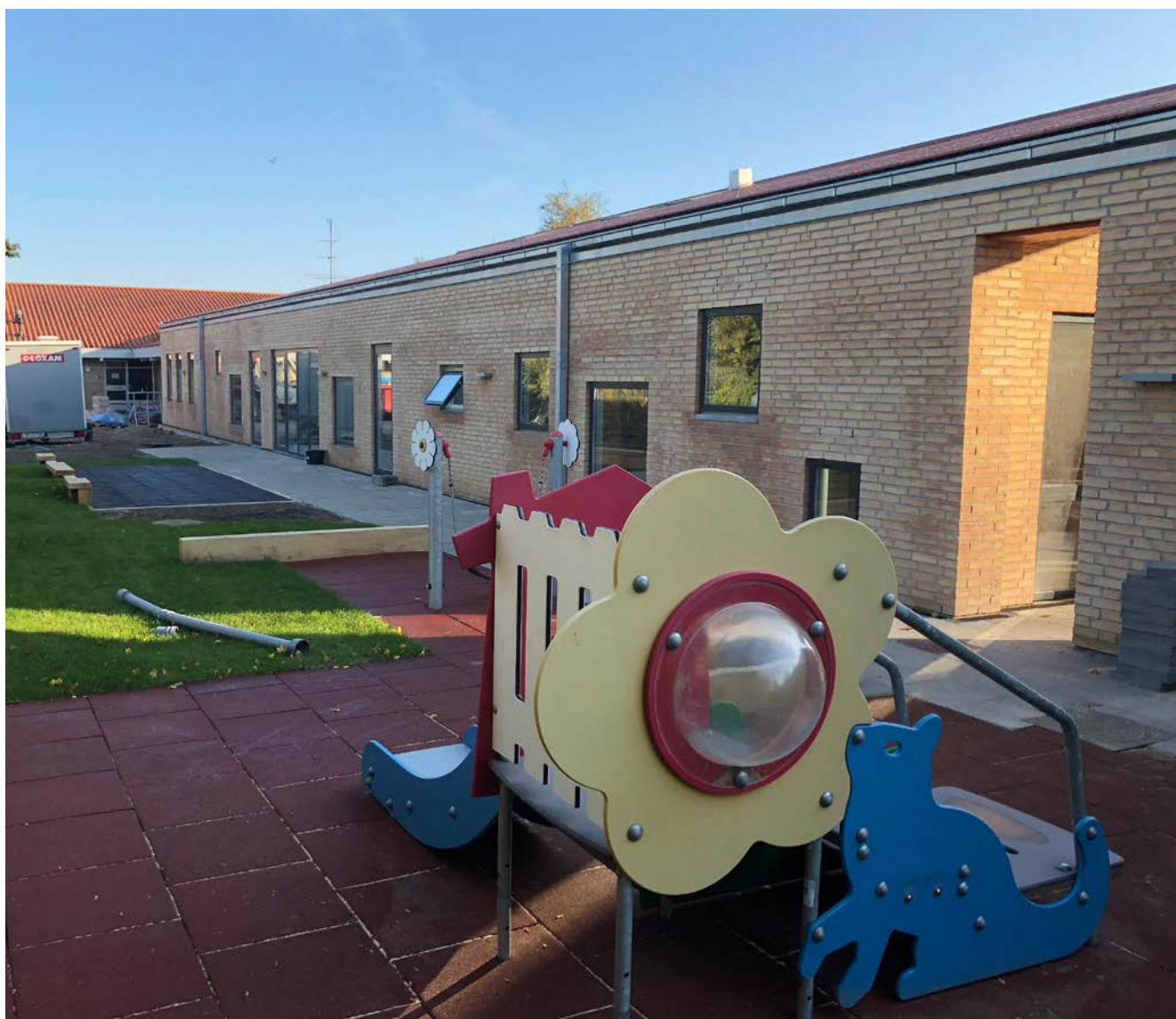
Den ny tilbygning er på 630 kvm og normeret til 60 børnehavebørn, 12 vuggestuebørn, en SFO og Nybøl gæstedagpleje. Den blev taget i brug i efterår 2018.
