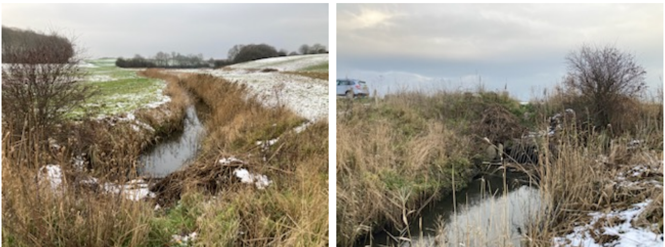
Figur 6: Fotos taget på besigtigelse d. 9. december 2022. Venstre foto viser rørlægningen set fra vejen mod syd. Foto til højre viser rørlægningen set ud mod kysten mod nord.
