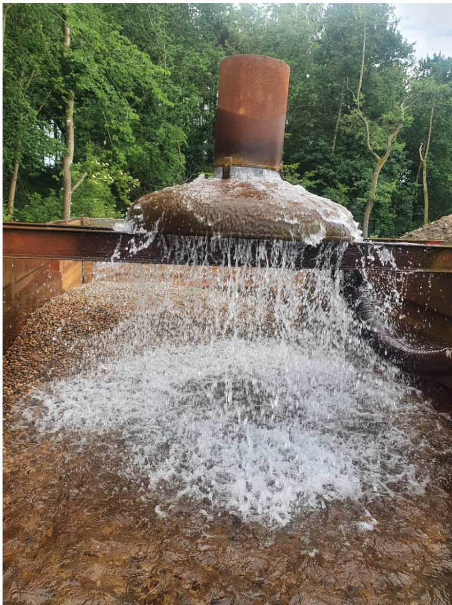
Figur 5. Figur 5 viser den del renseløsningen hvor vandet skal ledes henover iltningssystemet
