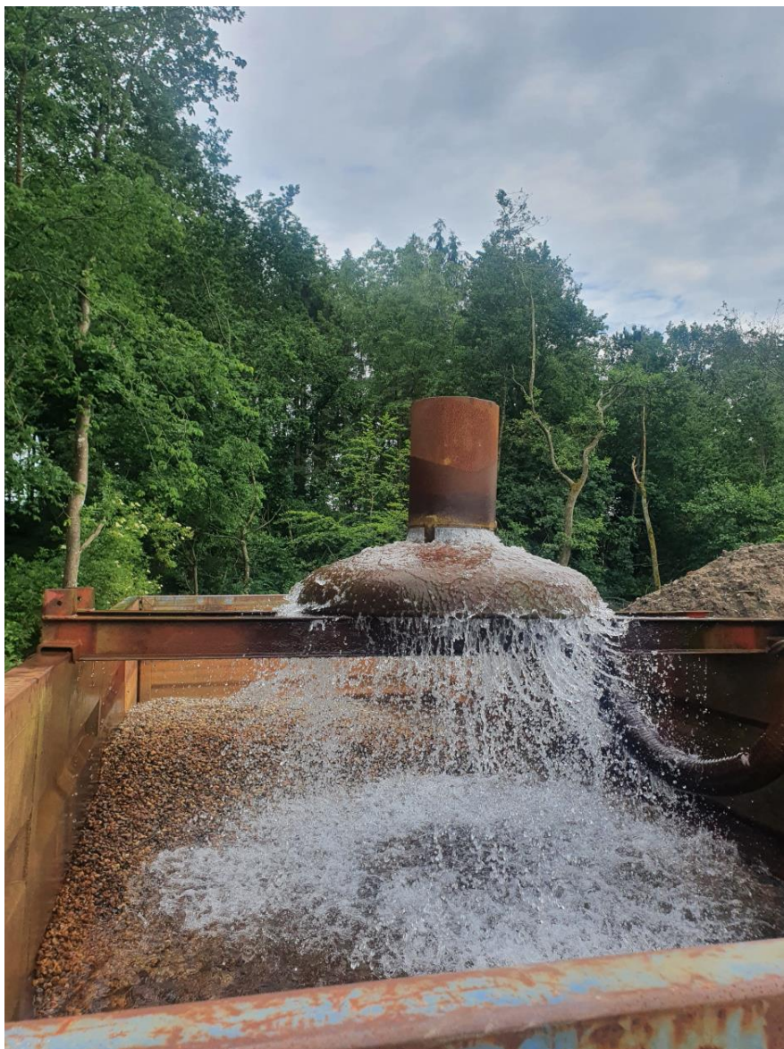
Figur 6. Andel af renseløsningen. Her ledes det iltede vand ned i container med filtermateriale
