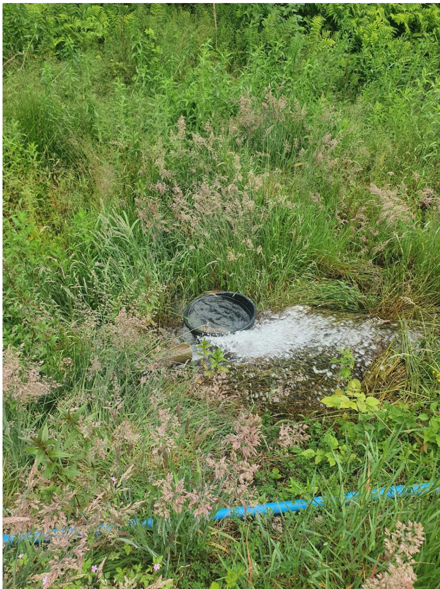
Figur 8. Figur 8 viser at fra udløbet ledes vandet via PVC-rør til recipienten.
