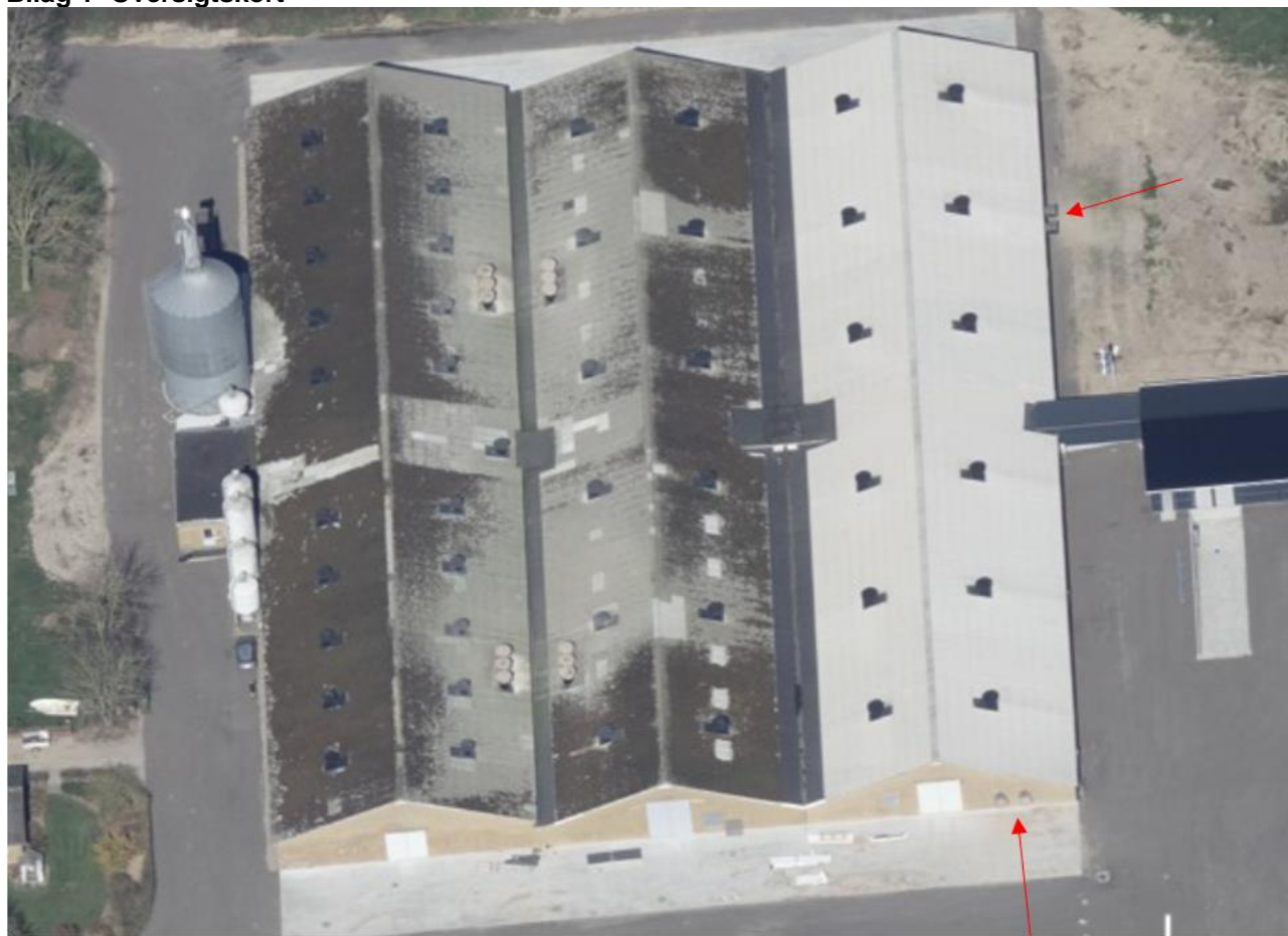
Luftfoto med angivelse af placering af ventilation
