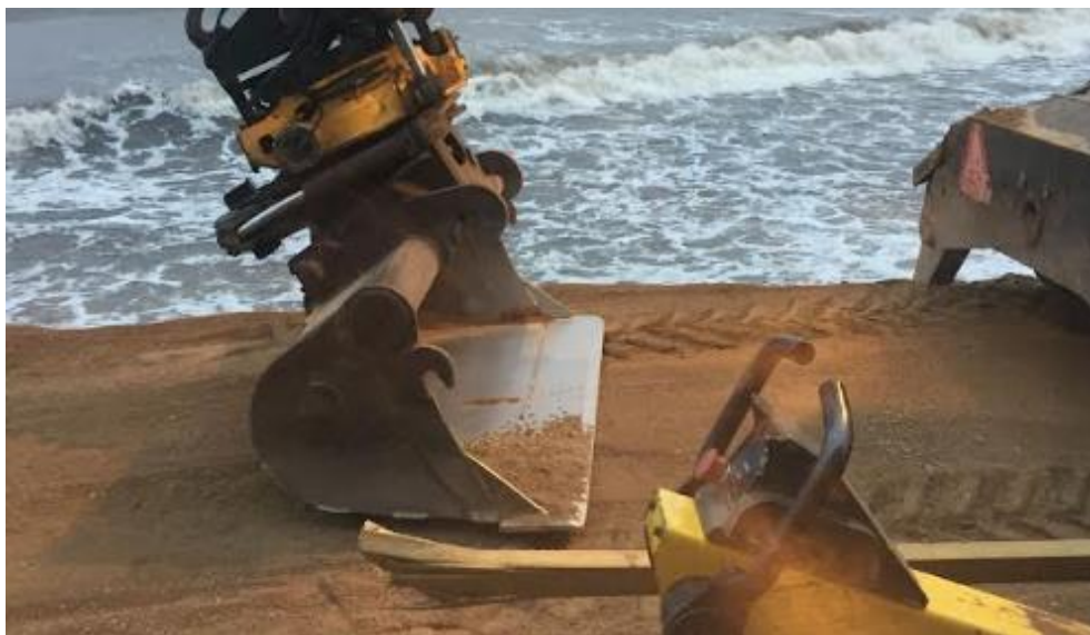
Figur 1 Indbygget materiale, modtaget af rekvirent.
