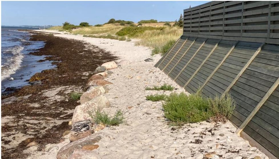
Figur 2 Marksten og træ-kystsikringen set fra strandsiden mod nordvest 24. august 2022.
