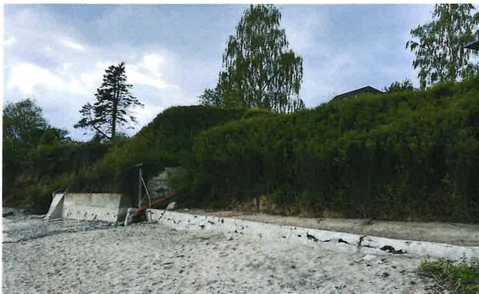
Figur 2-1 Foto af den gamle betonstøttemur som nu er fjernet, Sundgade 64, set mod vest i maj 2024. Til venstre ses en tilsvarende, men højere mur, på naboejendommen, Sundgade 70.
