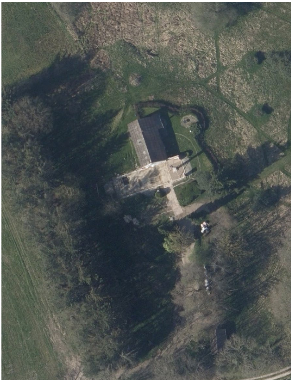
Genopførelse af fritidshus på eksisterende sokkel
