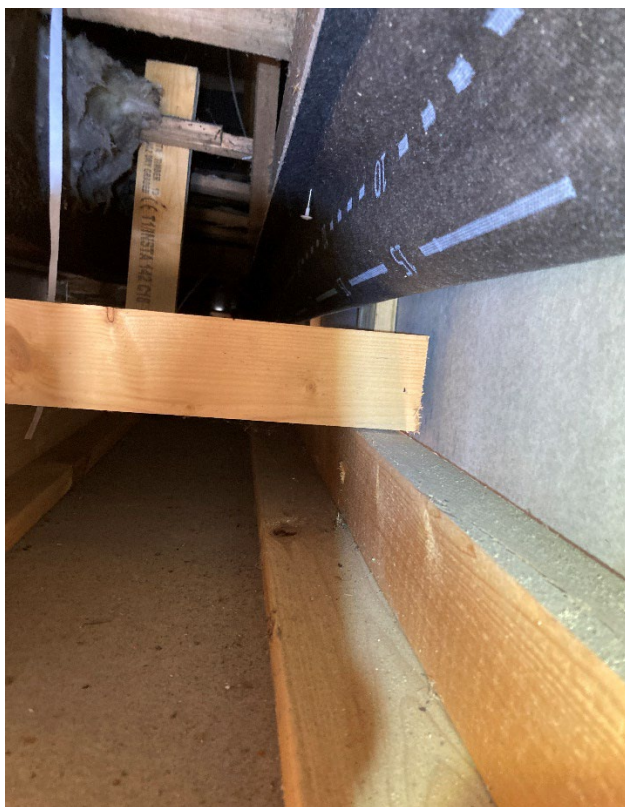
Figur 7: Nærbillede af tagrummet. Der var ikke spor efter kradsemærker, afbidte sommerfuglevinger eller ekskrementer. Dermed tyder intet på, at bygningen på noget tidspunkt har været anvendt af flagermus.
