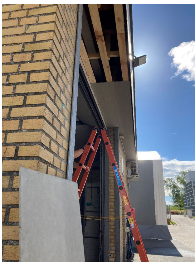
Figur 2: For at kunne foretage fysisk inspektion af tagrummet, blev en del af udhænget afmonteret.
