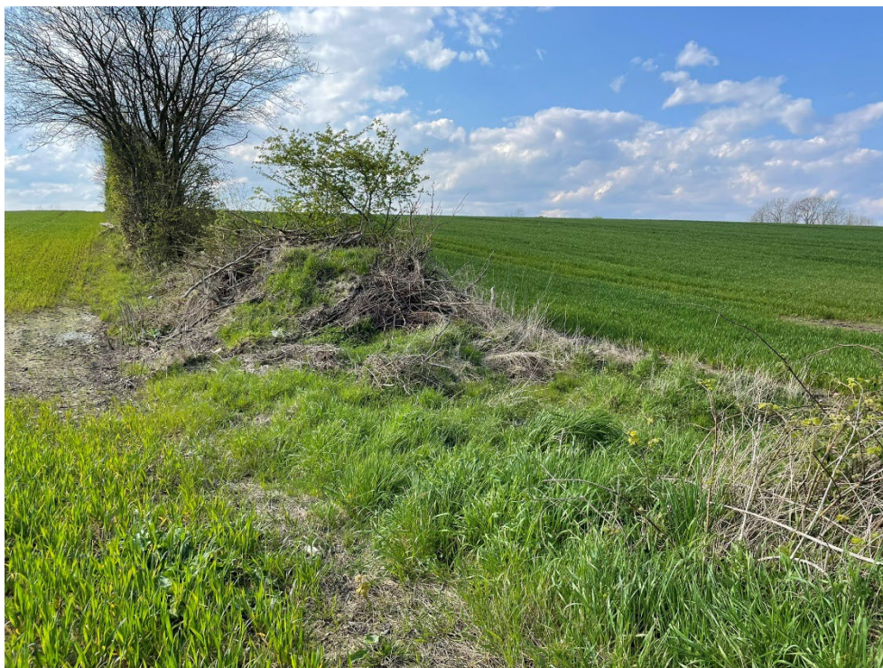
Figur 3-75 Dige N18D fungerer som terrænspring. Der er et brud i plantebæltet på diget, hvor der ligger en større kvasbunke. Foto er taget i retning mod nord-vest.
