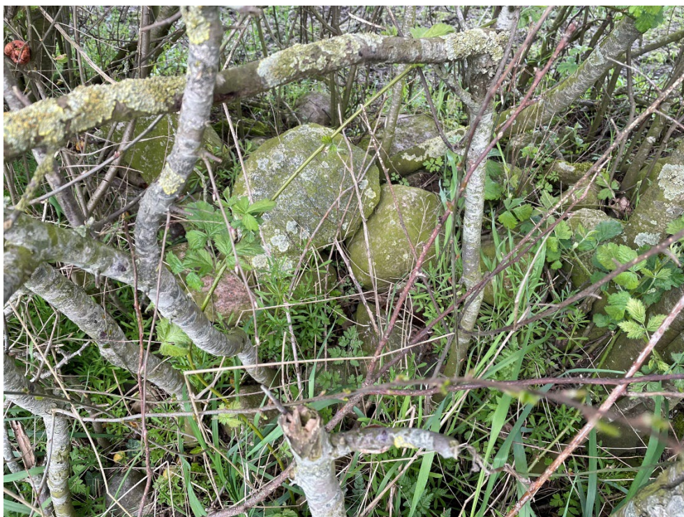
Figur 3-66 Stenbunke i diget.
