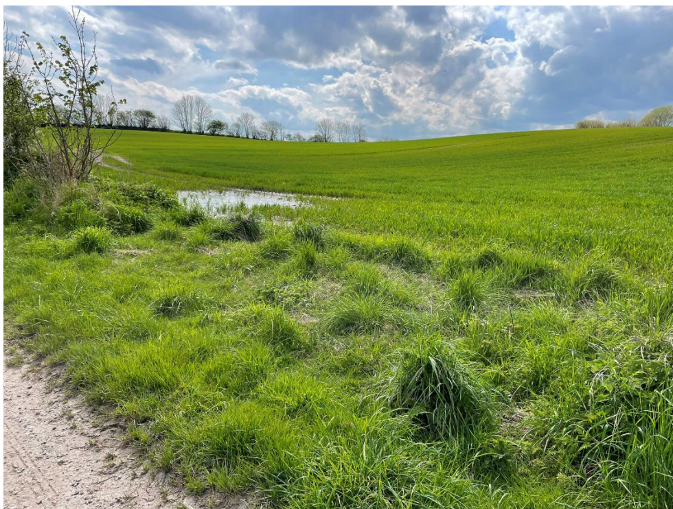
Figur 3-83 Digebrud i N20D hvor der er skabt adgang mellem Skovvej og den dyrkede mark mod vest. Foto er taget i retning mod sydvest.
