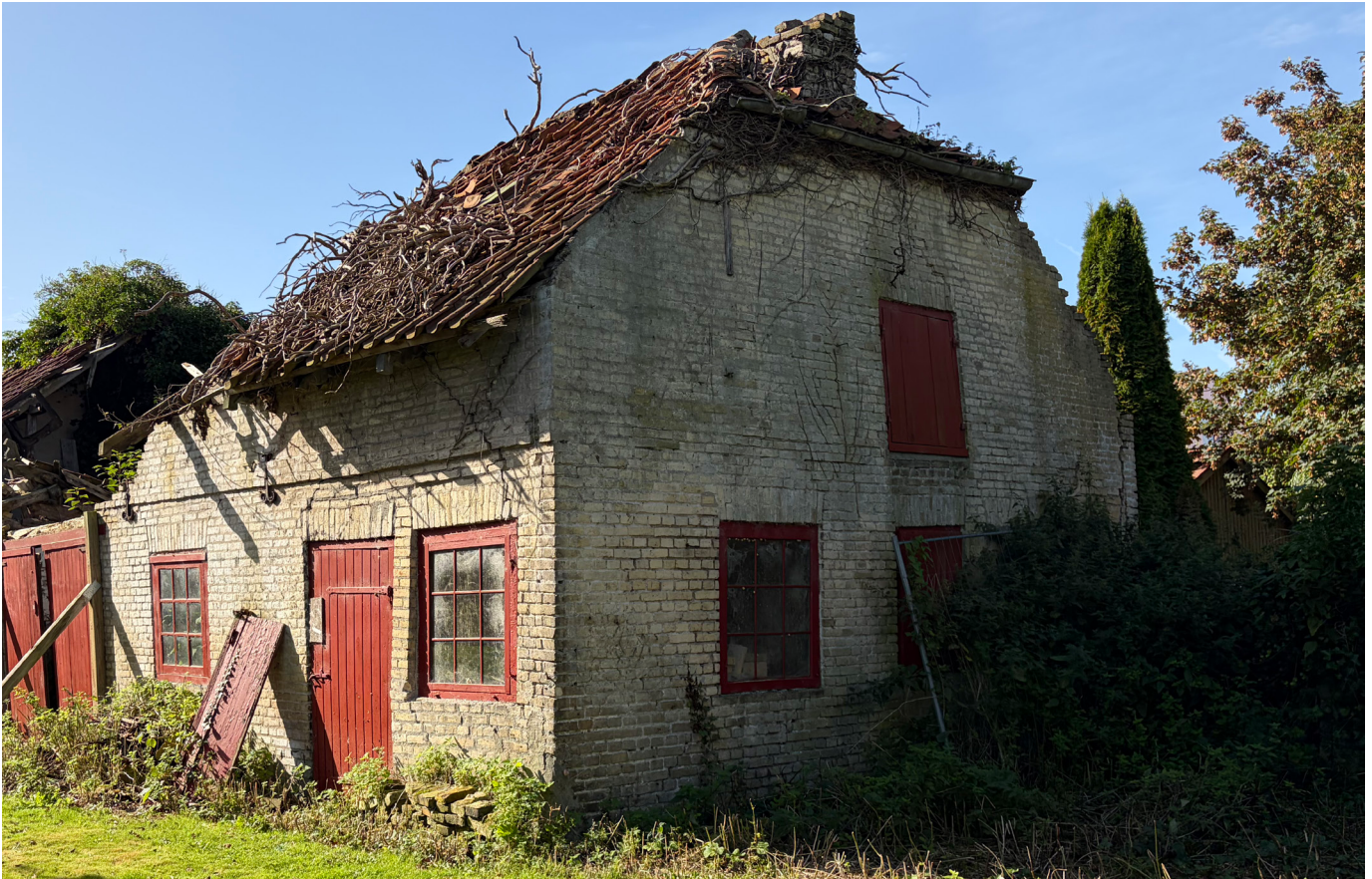
Foto af bygning 3: sydlige facade og nordlige gavl.
