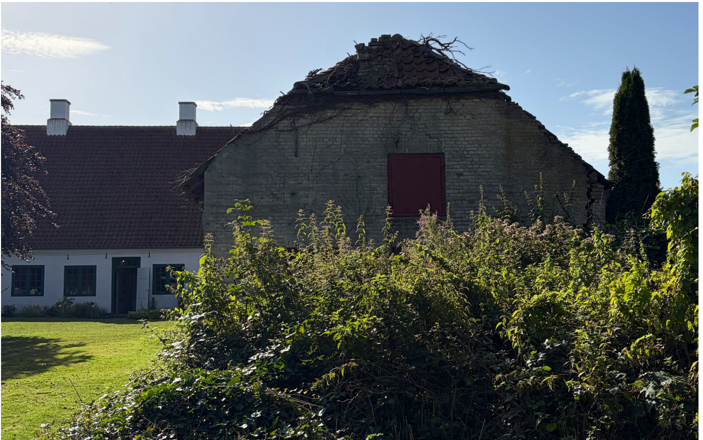
Foto af bygning 3: nordlige gavl.
