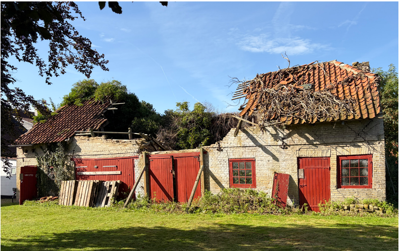
Foto af bygning 3: sydlige facade.
