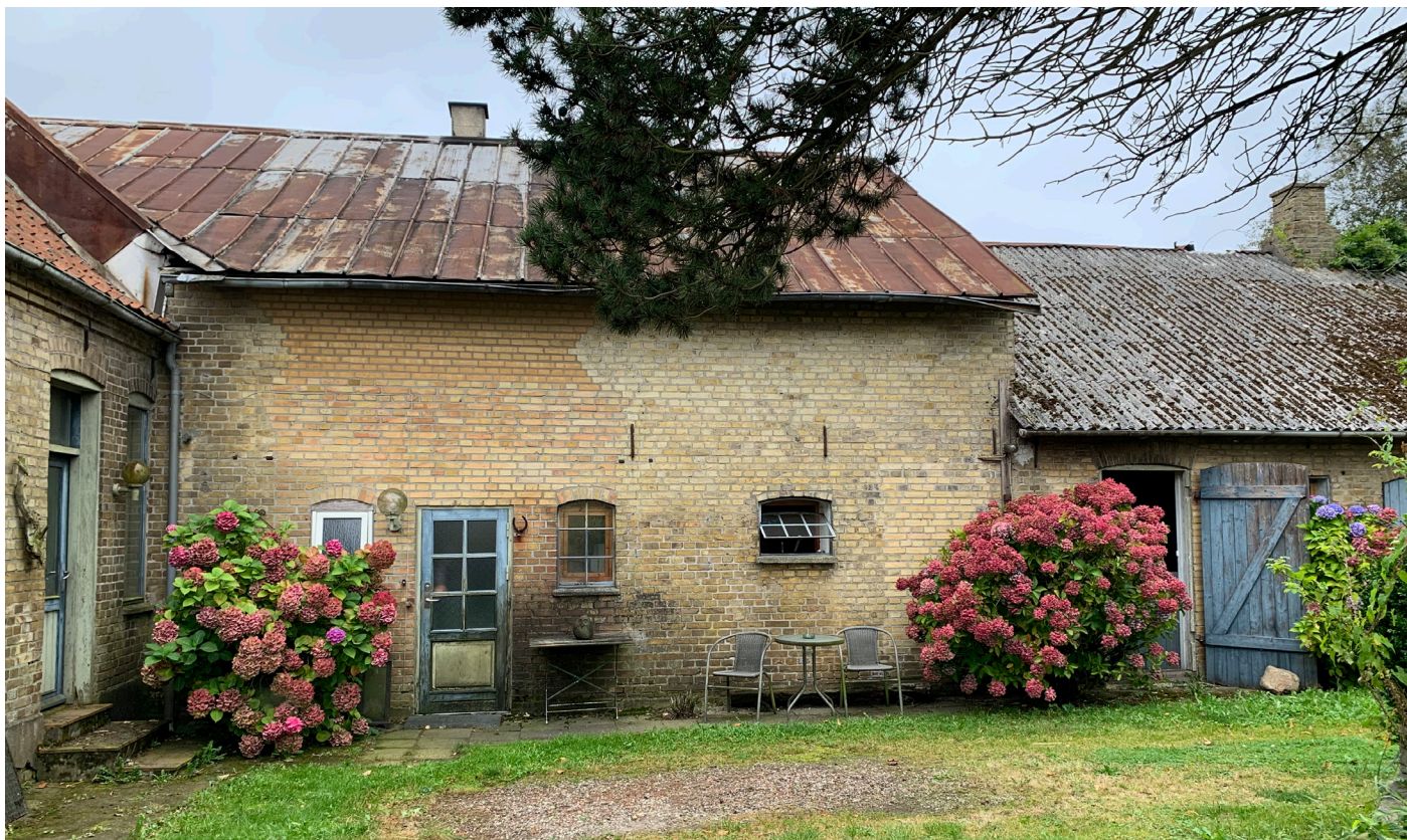
Bygning 2: øst facade.
