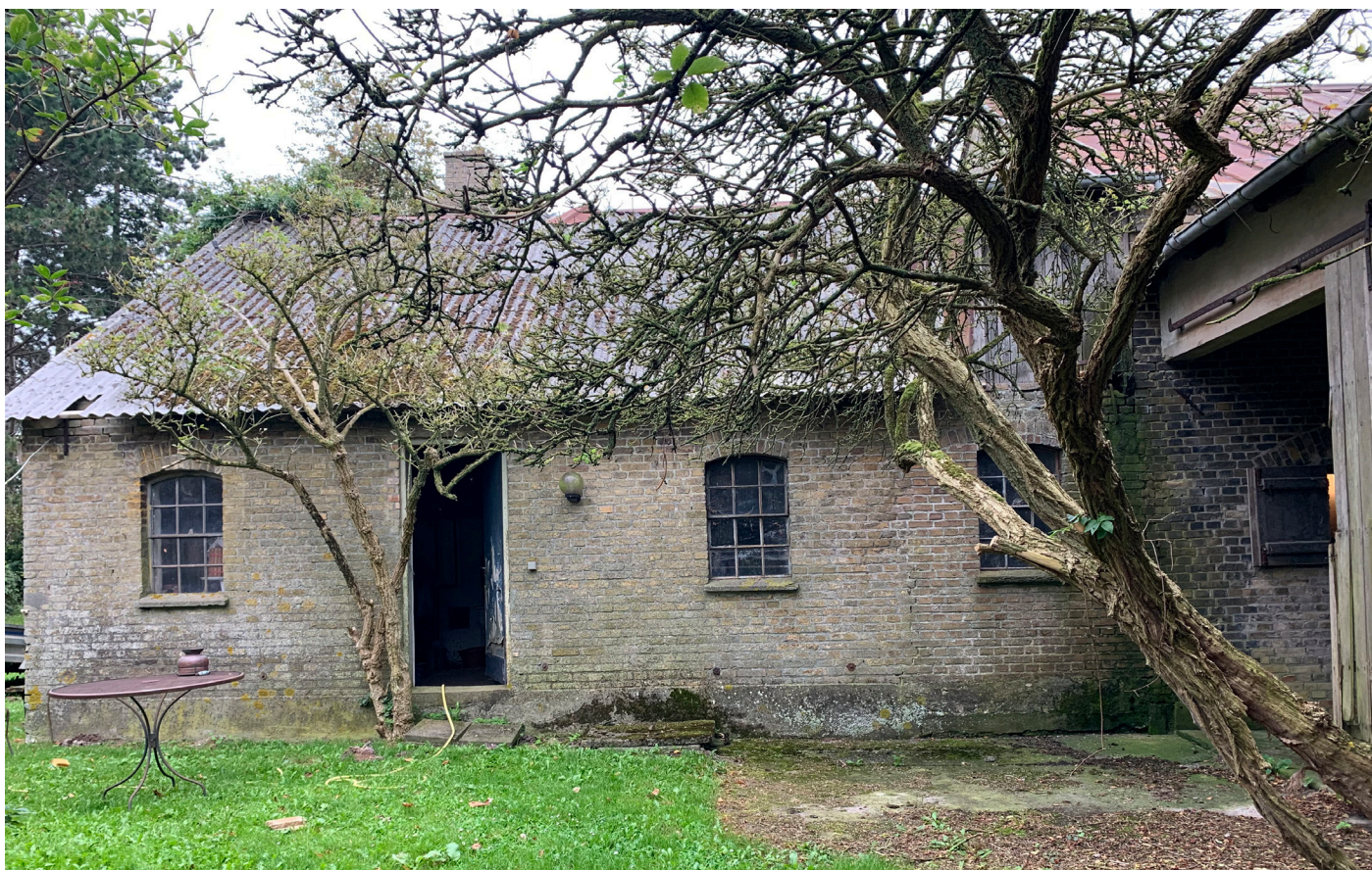
Bygning 2: vest facade.
