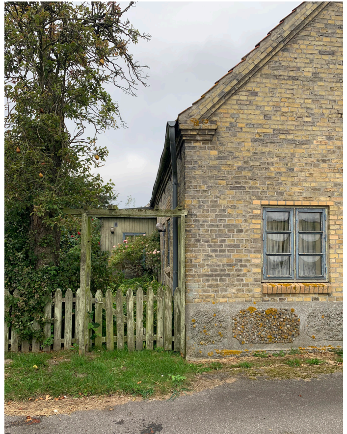
Bygning 1: øst gavl.
