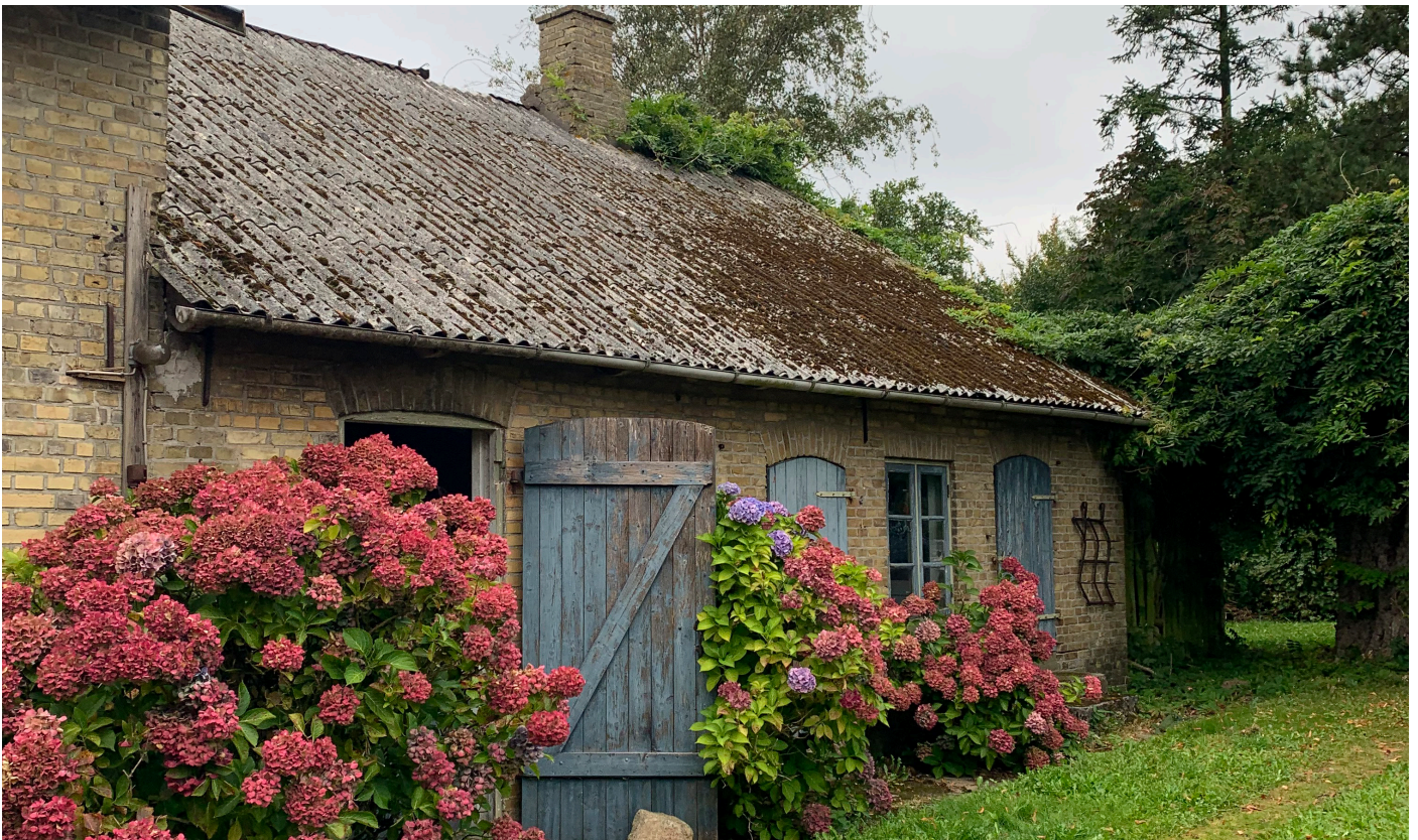
Bygning 5: øst gavl.
