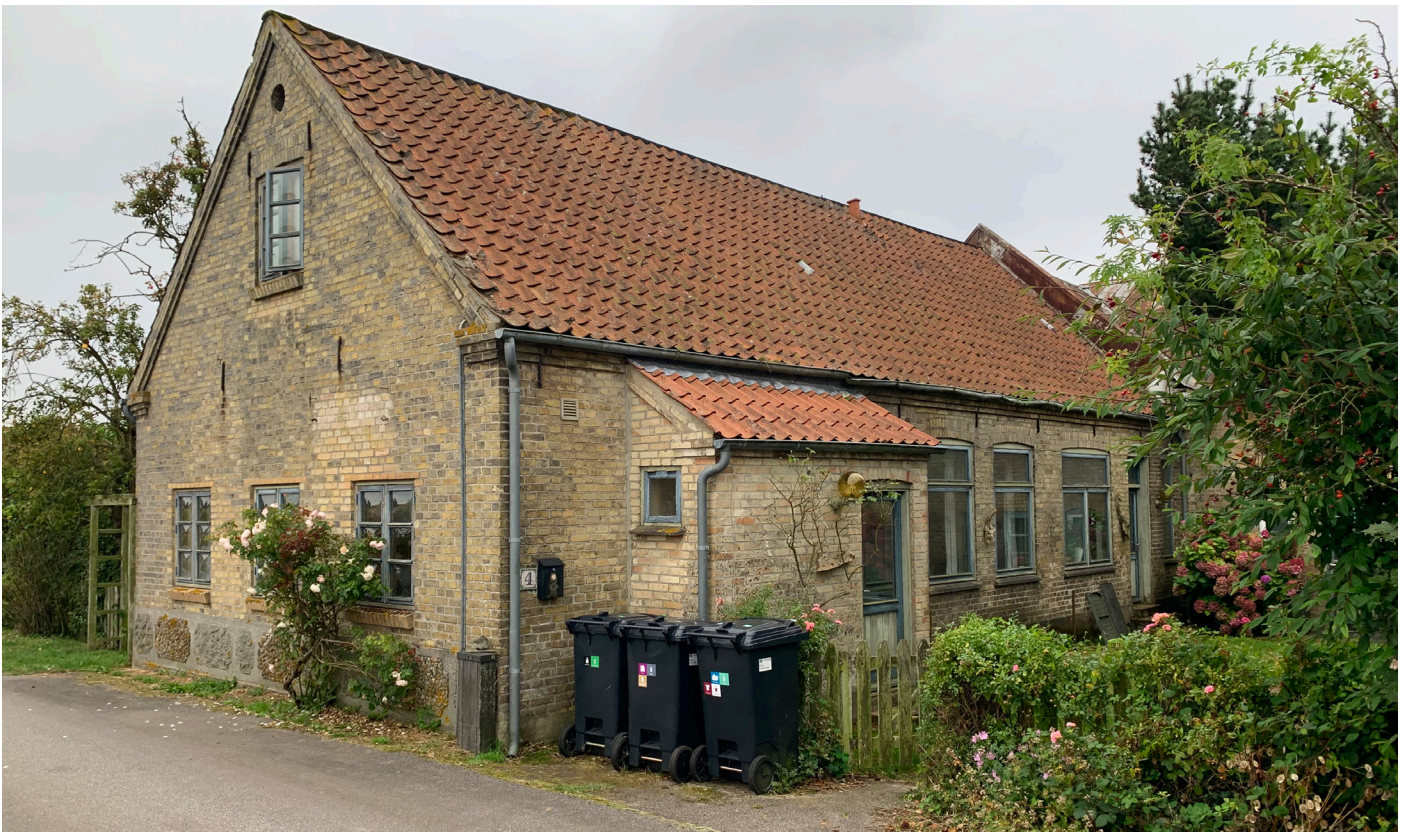
Bygning 1: nord facade og øst gavl.
