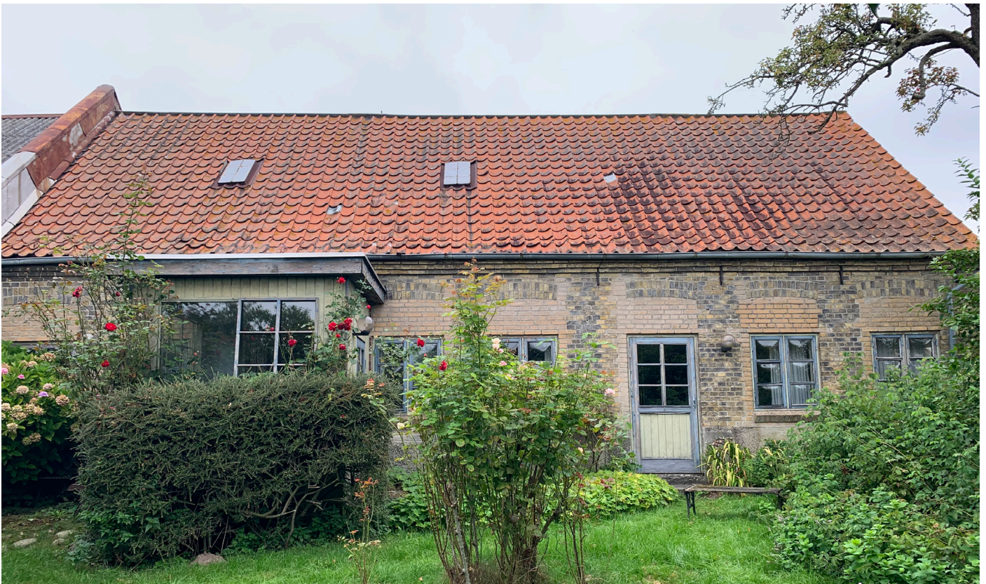
Bygning 1: syd facade.
