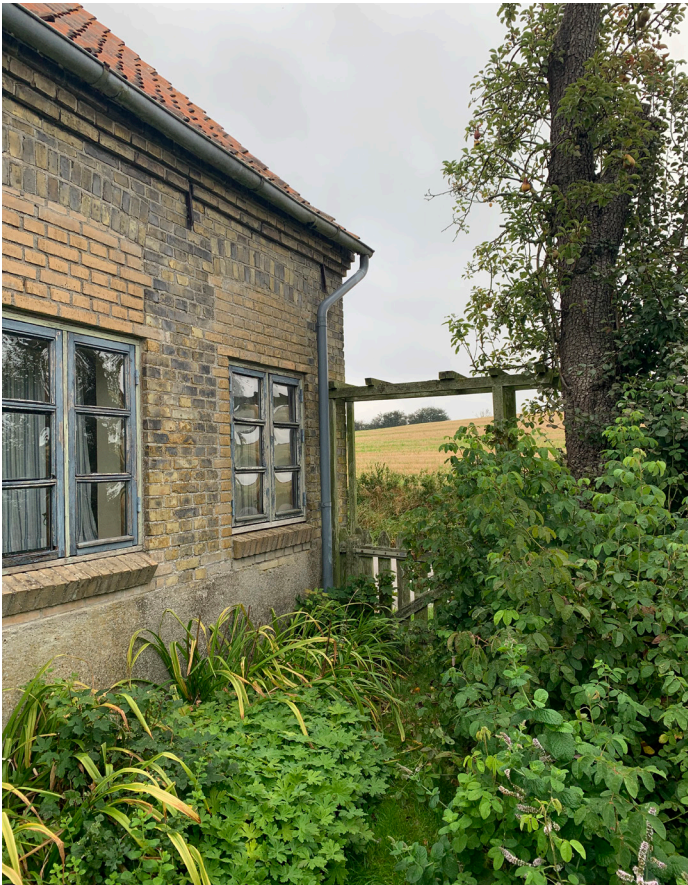
Bygning 1: syd facade.
