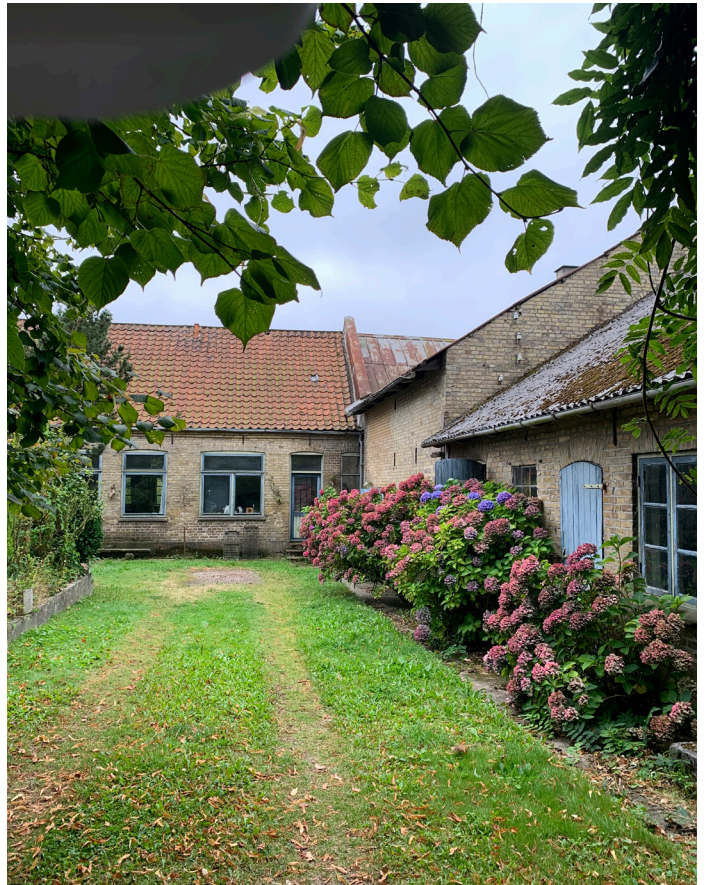
Bygning 1: nord facade.
