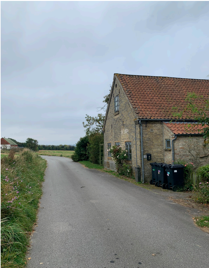
Bygning 1: ejendommen set fra vejen fra nord.
