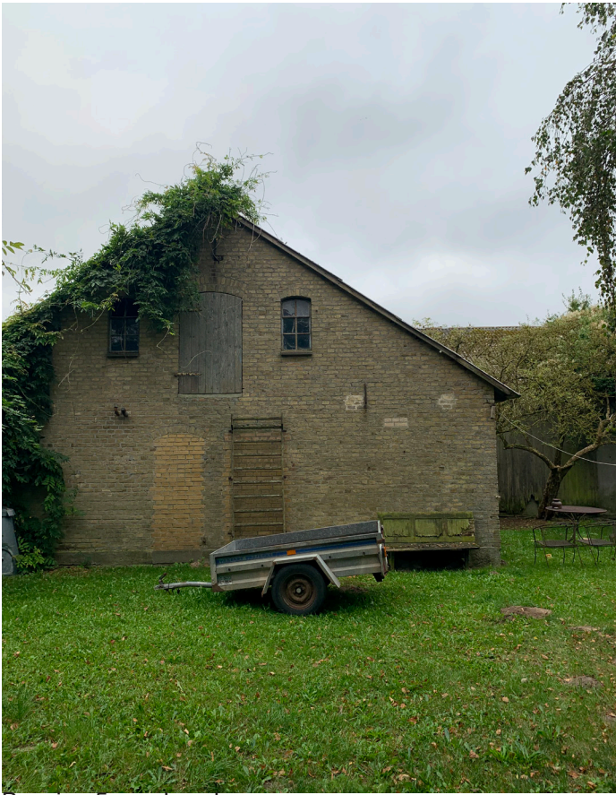
Bygning 5: nord gavl.
