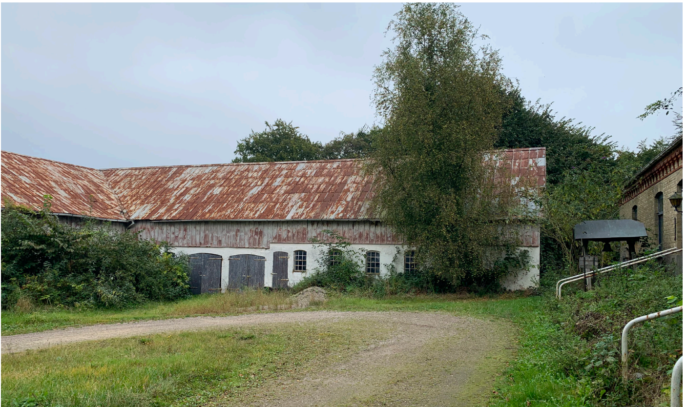
Bygning 4: øst facade.
