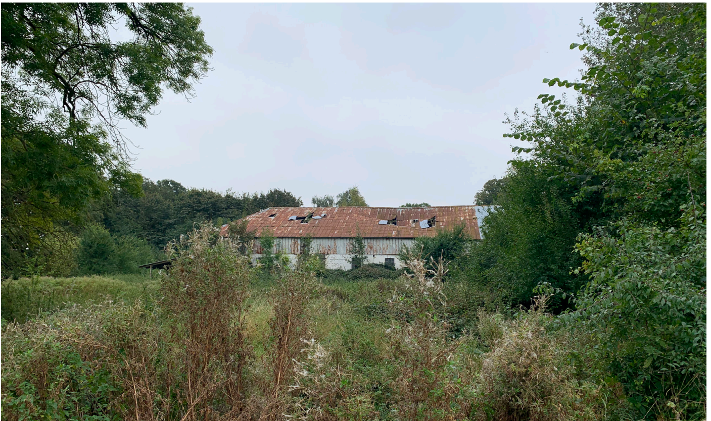
Bygning 3: nord facade.
