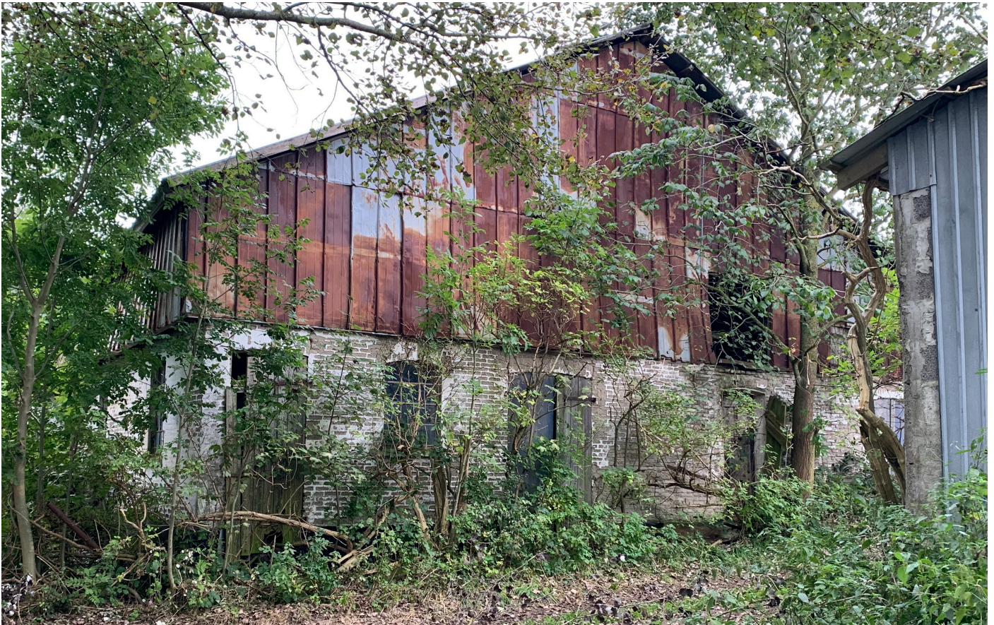
Bygning 3: vest facade.
