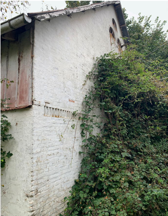
Bygning 4: syd gavl.
