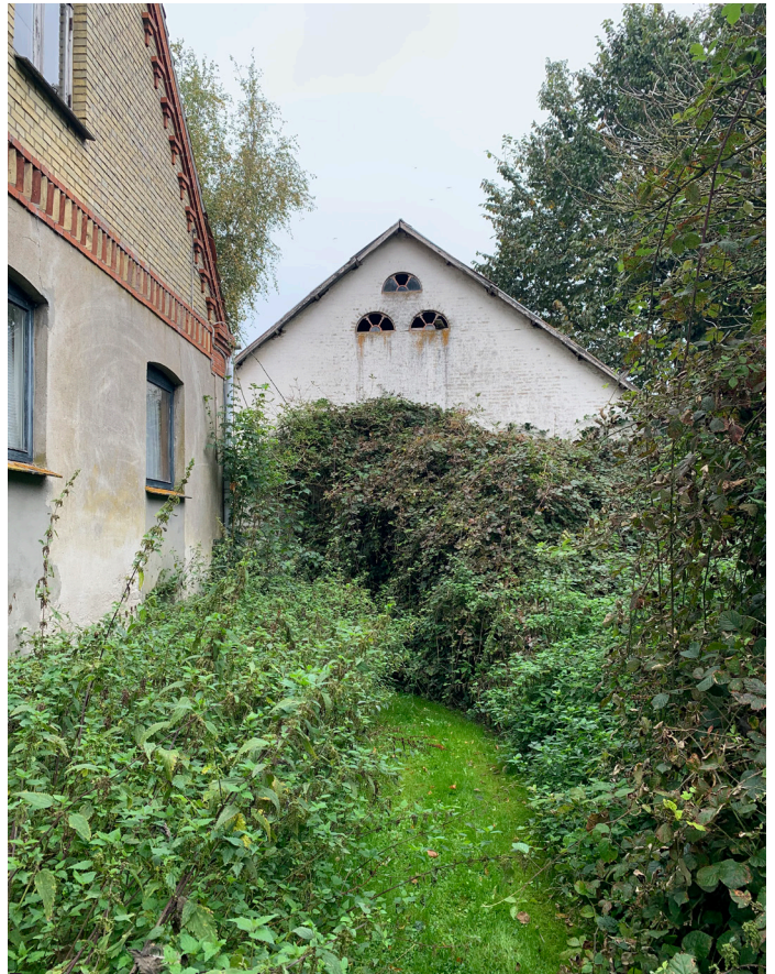
Bygning 4: syd gavl.
