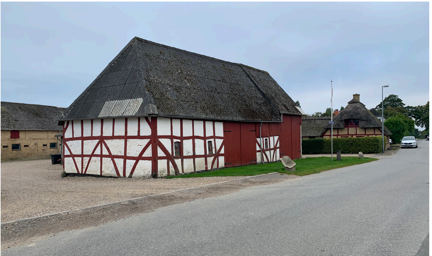
Bygning 3: nord facade og vest gavl.
