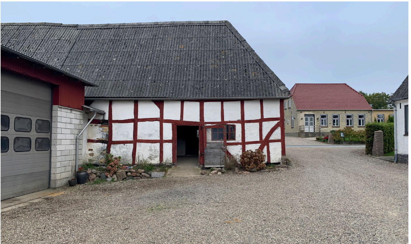
Bygning 3: syd facade.
