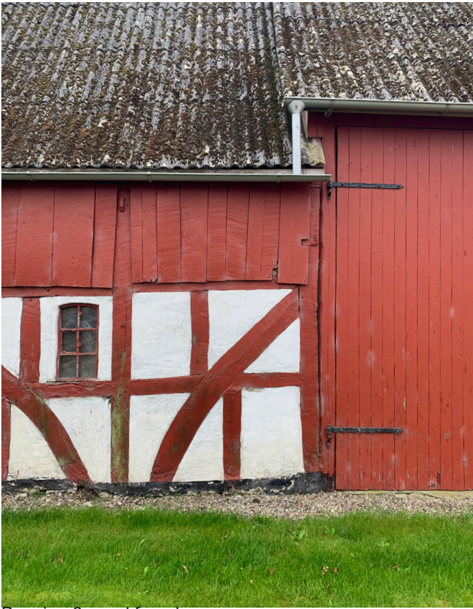
Bygning 3: nord facade.
