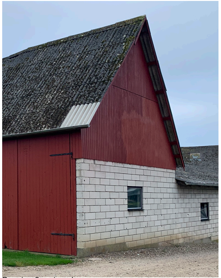
Bygning 3: øst gavl.
