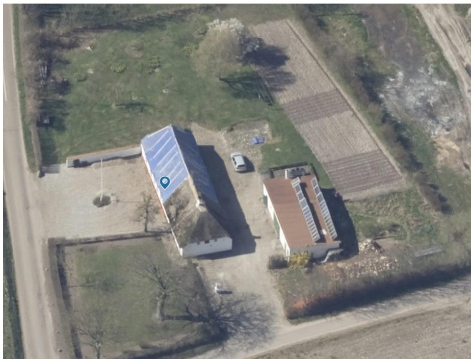
Skråfoto som viser solceller vinklet på taget af udhusbygning, Skråfoto, Klimadatastyrelsen 2023.
