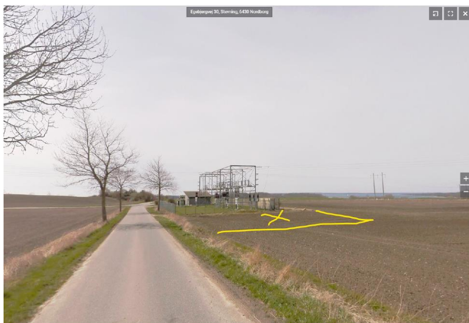
Eksisterende transformerstation set fra nord med angivelse af ca. placering af areal til udvidelse. Fra ansøgningen.
