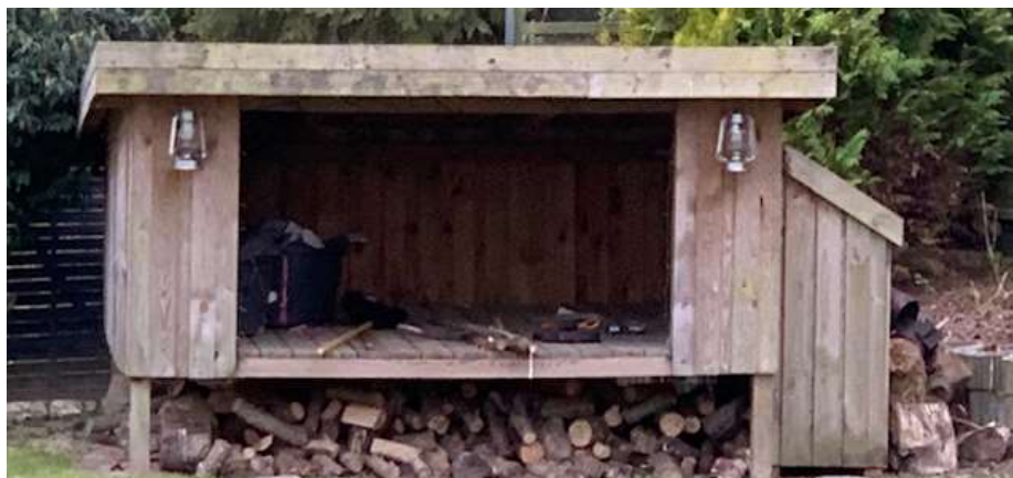
Foto som viser det opførte shelter.
