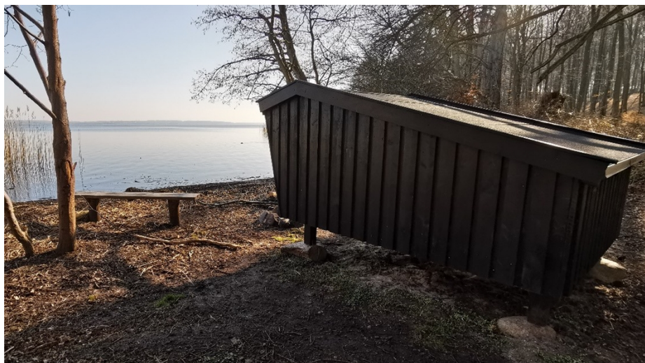
Figur 1 - Mini shelter opsat i Nordsjælland
