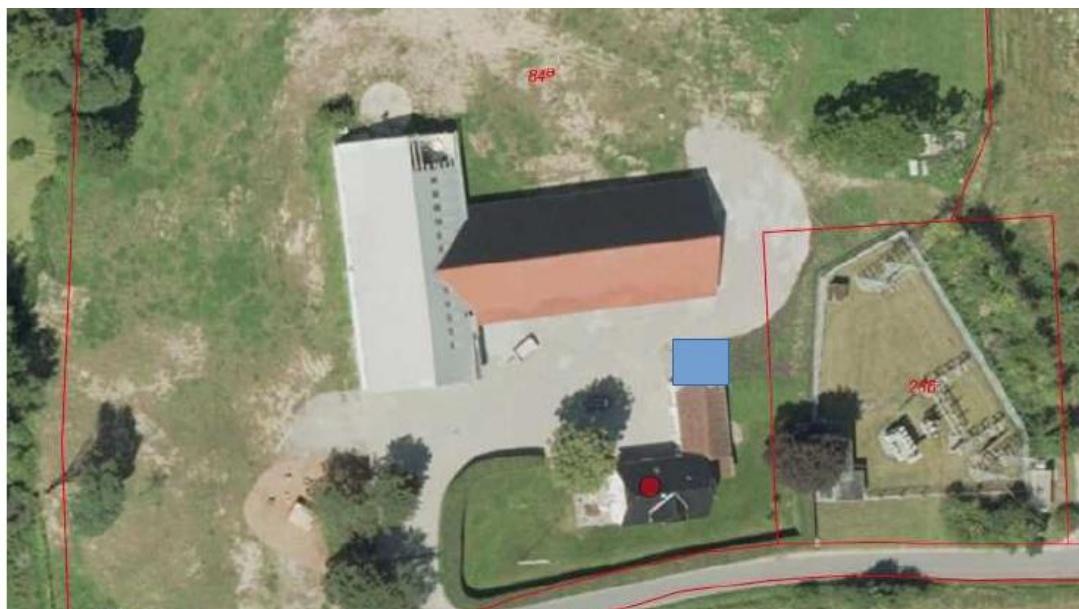
Luftfoto som viser udvidelsen af garagen mod nord med blå firkant.
