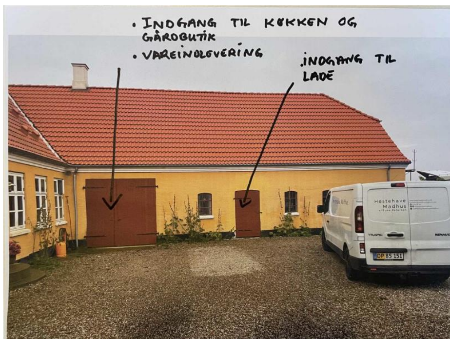
Foto af udhuset, hvor indgange til køkken/gårdbutik samt lade er markeret.
