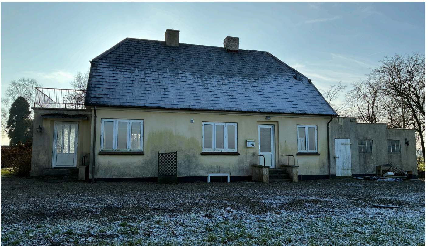
Bygningen set mod syd
