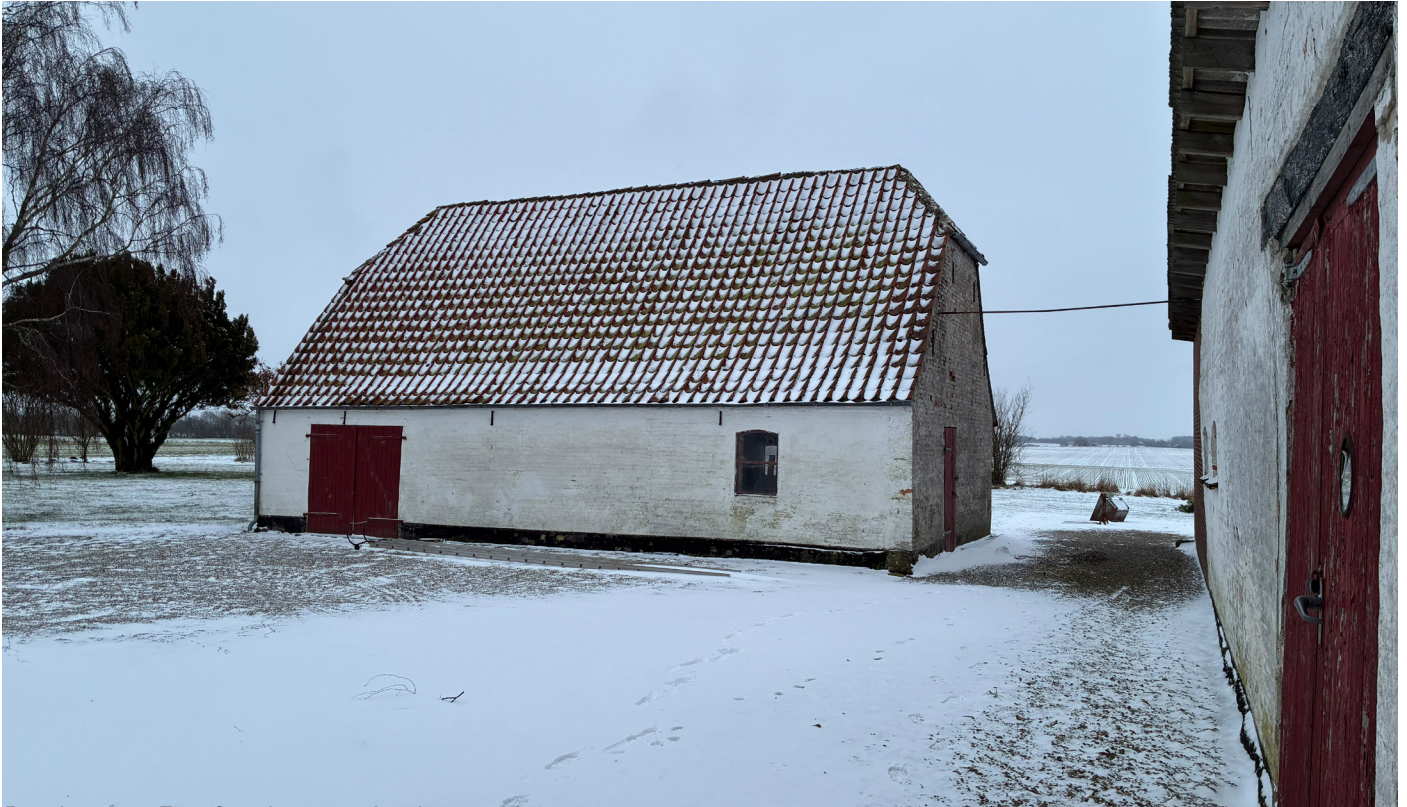
Bygning nr. 5. Frontfacade set mod syd
