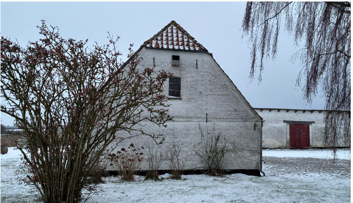
Bygning nr. 5. Set mod vest
