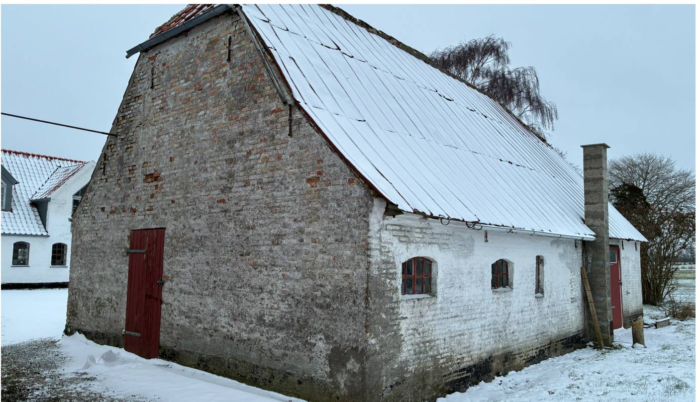
Bygning nr. 5. Set mod øst
