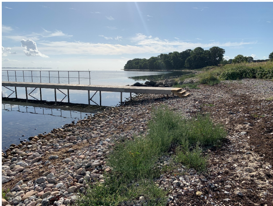
Figur 2. Broen er opsat. Der gives ikke tilladelse til gelænderet.
