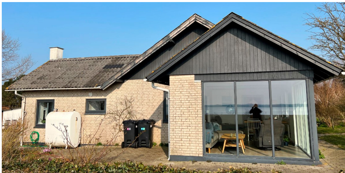
Foto af eksisterende hus set fra vest
