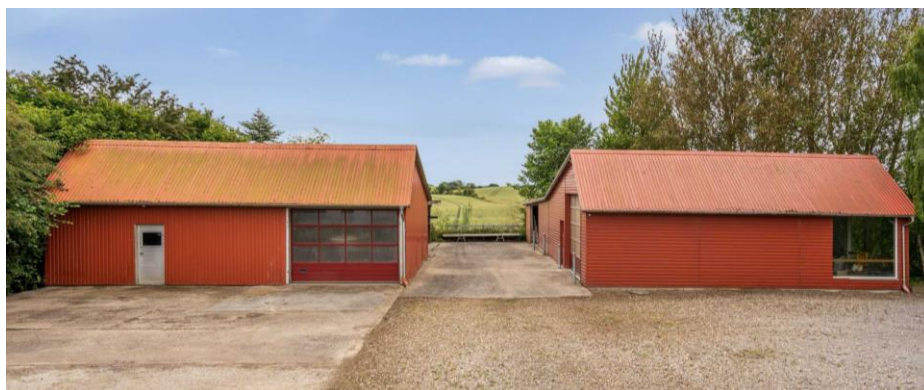
Foto af lagerbygningerne, fra ansøgningen.
