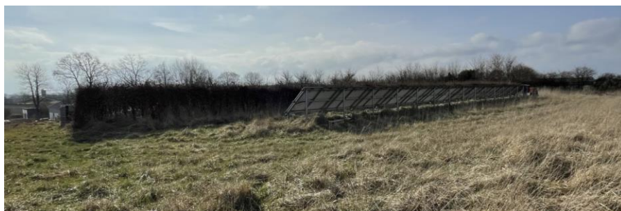
Billede fra besigtigelse den 25. februar 2025 – Eksisterende solceller set fra nord mod syd.
