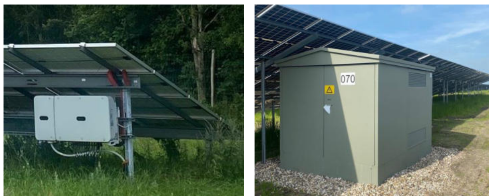
Figur 1-5 Eksempel på inverter (t.v.) og distributionstransformer (t.h.).
