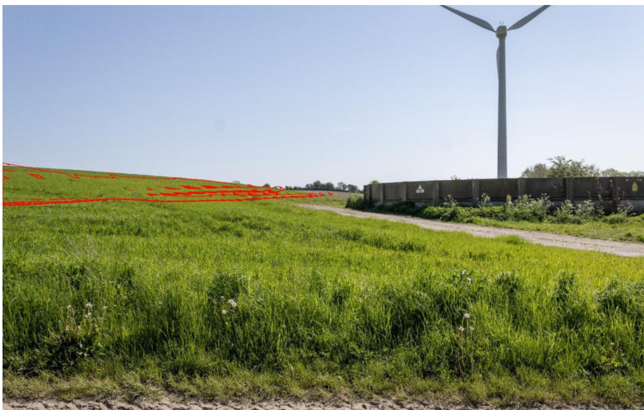
Figur 4-17 Eksisterende forhold set fra fotostandpunkt 2 (Arnbjergvej), hvor solcelleanlæggets placering og udbredelse er vist med rødt omrids. Solcelleanlægget er placeret bagved en bakke, og vil derfor kun i begrænset omfang være synlig fra dette fotostandpunkt.
