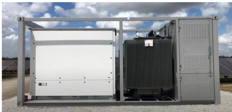
Figur 1-6 Eksempel på centralinverter.
