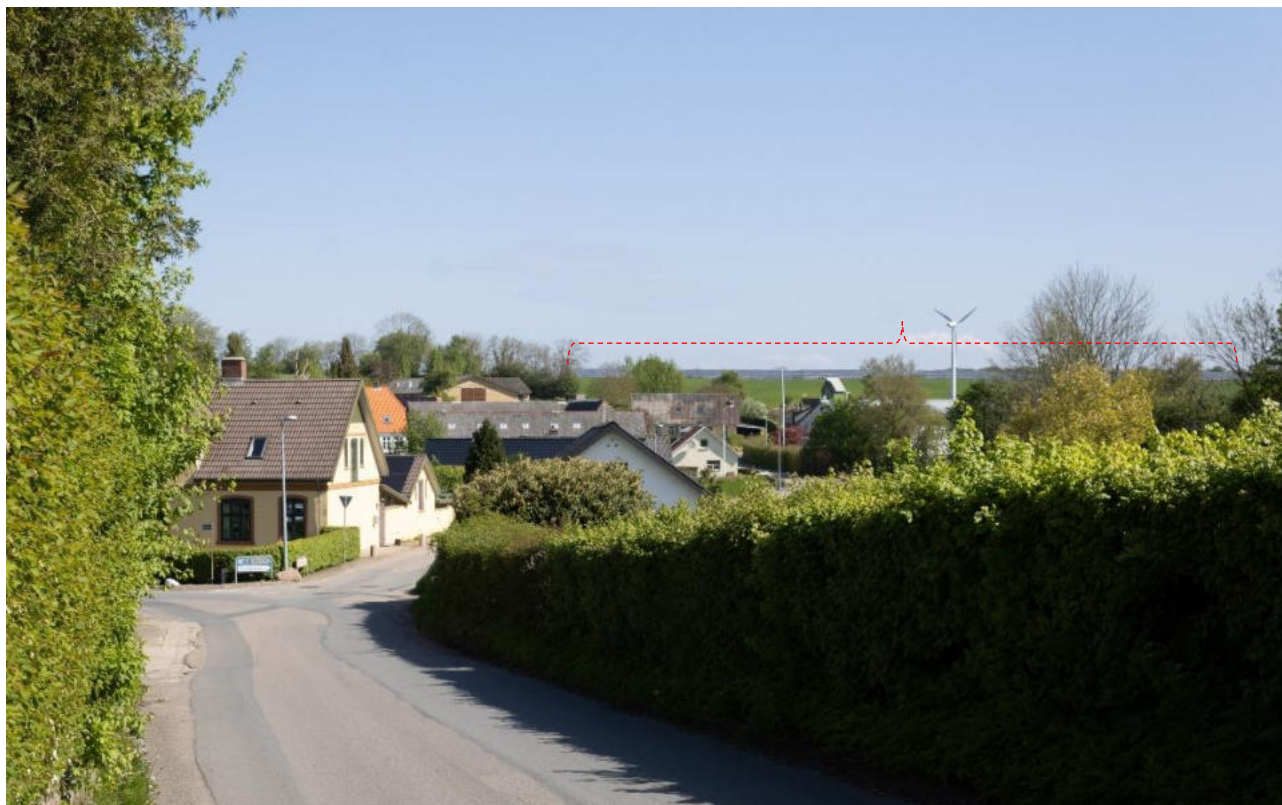
Figur 4-21 Visualisering af solcelleanlægget uden afskærmende beplantning set fra fotostandpunkt 3 (Arnbjergvej). Anlægget er synligt i horisonten fra fotostandpunktet, men er delvist sløret af mellemliggende terræn. Synlige dele af anlægget er vist med rød stilet klamme.
