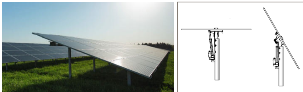
Figur 1-4 Eksempel på solcellepaneler med fast hældning (t.v.) og trackersystem (t.h.)
