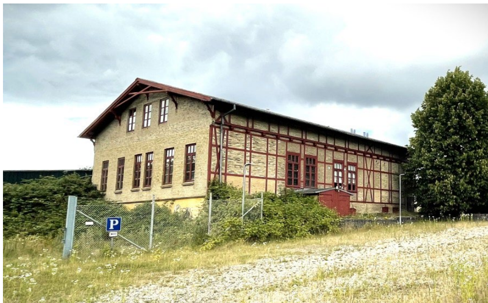
Figur 8-4 viser bygning nr. 7. Foto © Sønderborg Kommune
