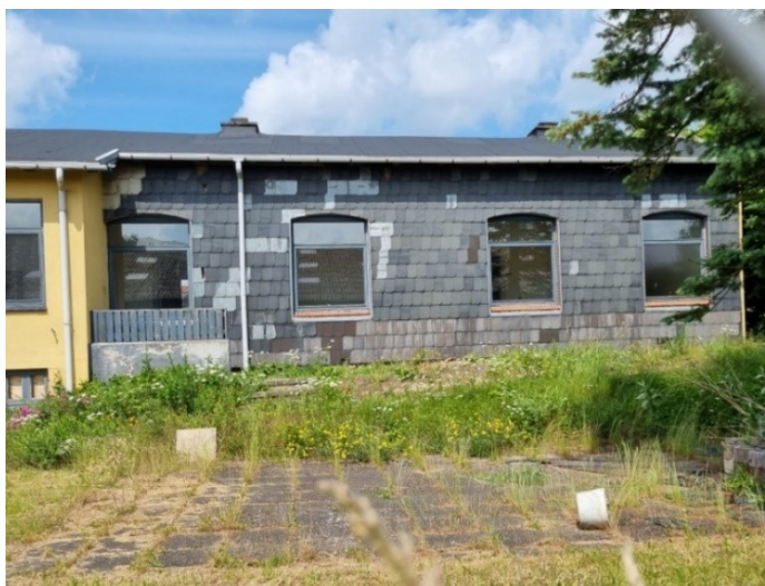
Figur 5. Skovvej 4, institutionen Blæksprutterne. Ved skifferplade beklædningen på sydøst vægen ses der huller og spalter, oplagte opholdssteder for flagermus.
