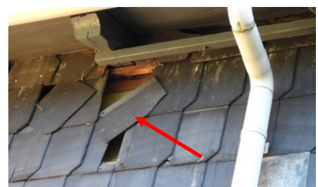
Figur 5. Skovvej 4, institutionen Blæksprutterne. Ved skifferplade beklædningen på sydøst vægen ses der huller og spalter, oplagte opholdssteder for flagermus.
