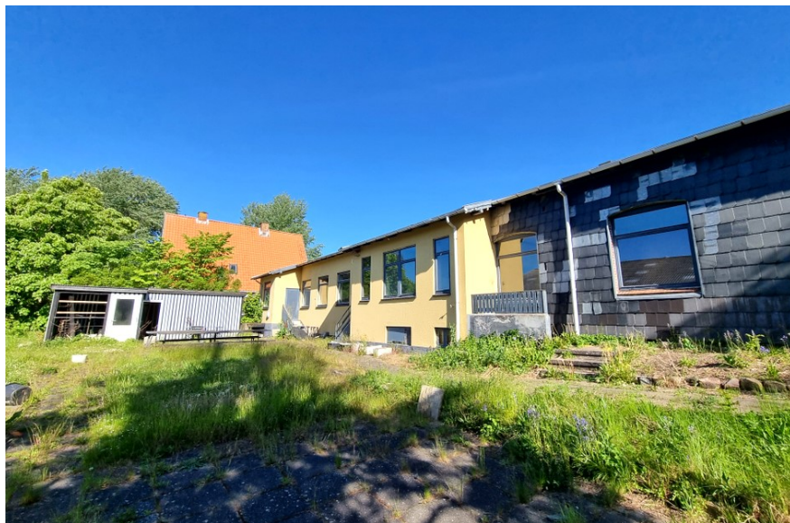
Bygningen blæksprutten set fra sydøst
