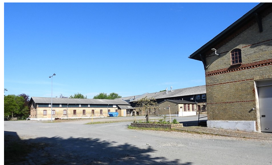
Hovedbygning med gårdsplads syd, vest og øst fløj
