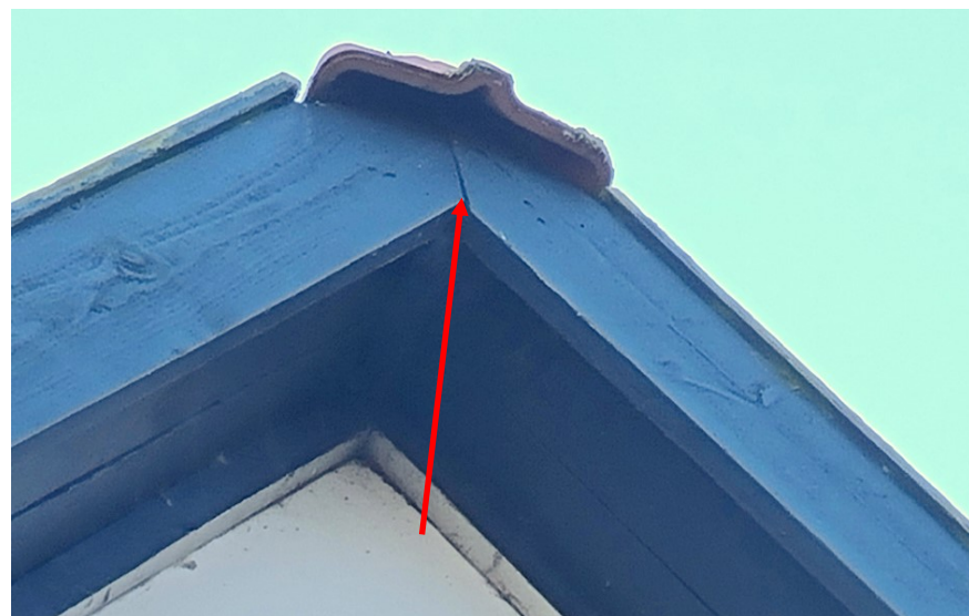
Portnerbolig -syd gavl – indgang ved rygningstagsten
