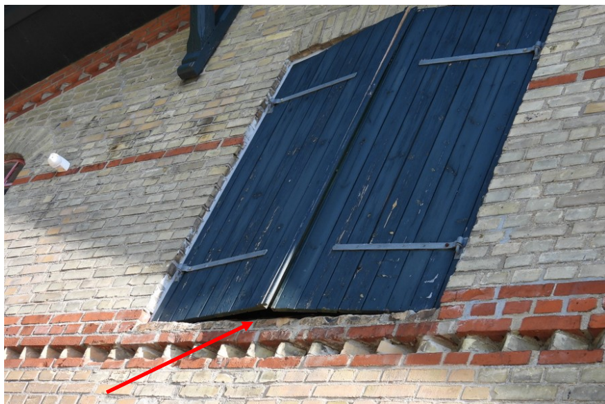
Sidebygning øst – spalte ved gavl luger
