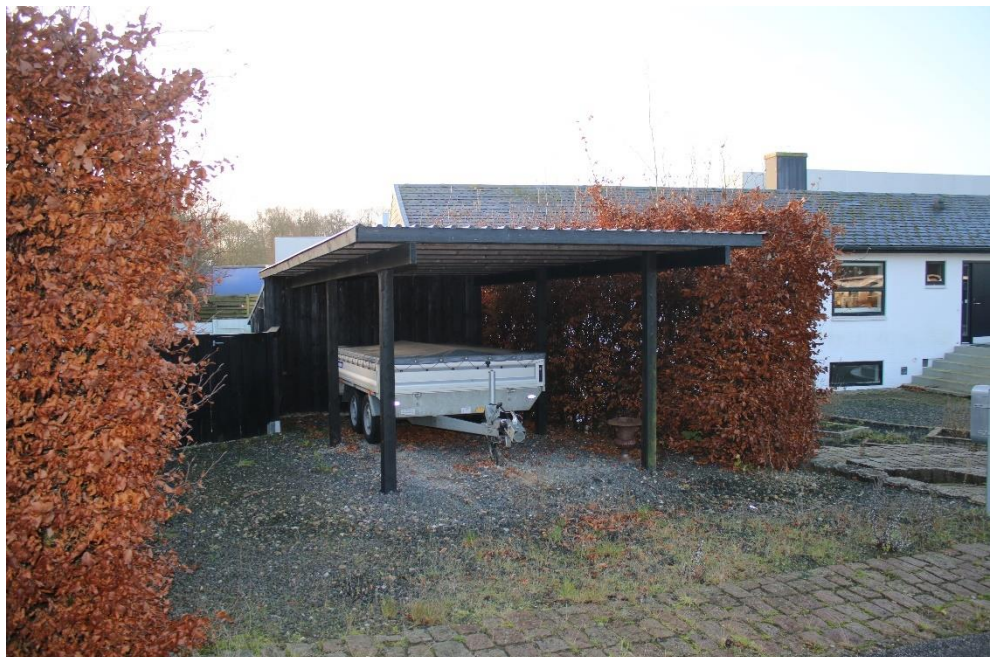
Figur 5-33 Carport set fra nord.
