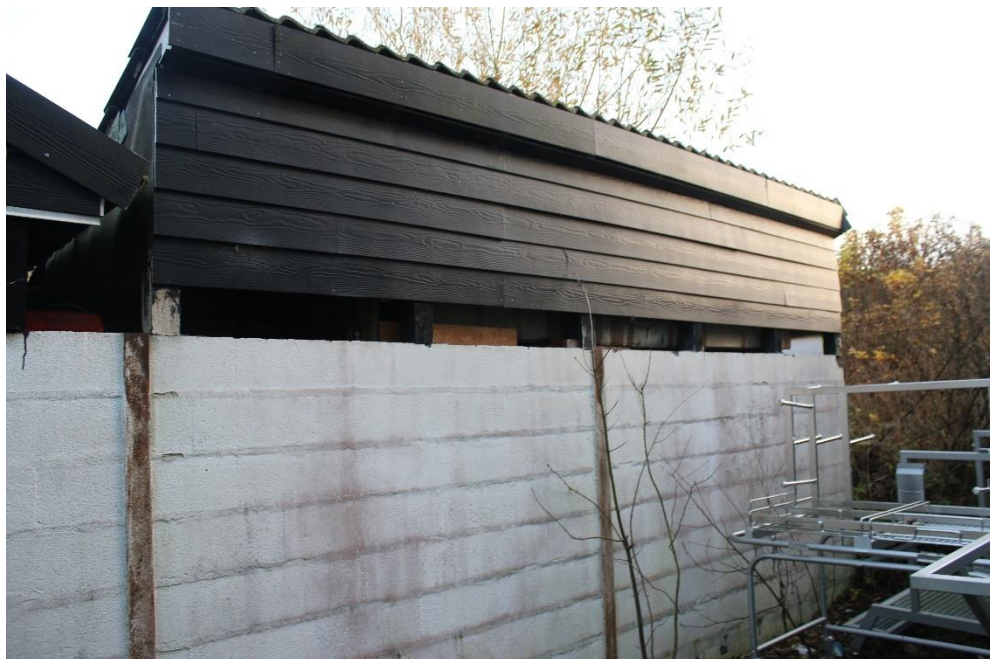
Figur 5-29 Garagen fremstår ligeledes meget åben pga. manglende brædder, og yder derfor ringe beskyttelse imod rovdyr.
