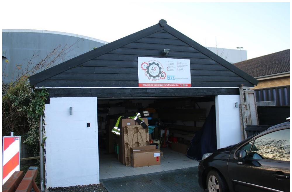
Figur 5-21 Garage set fra nord.
