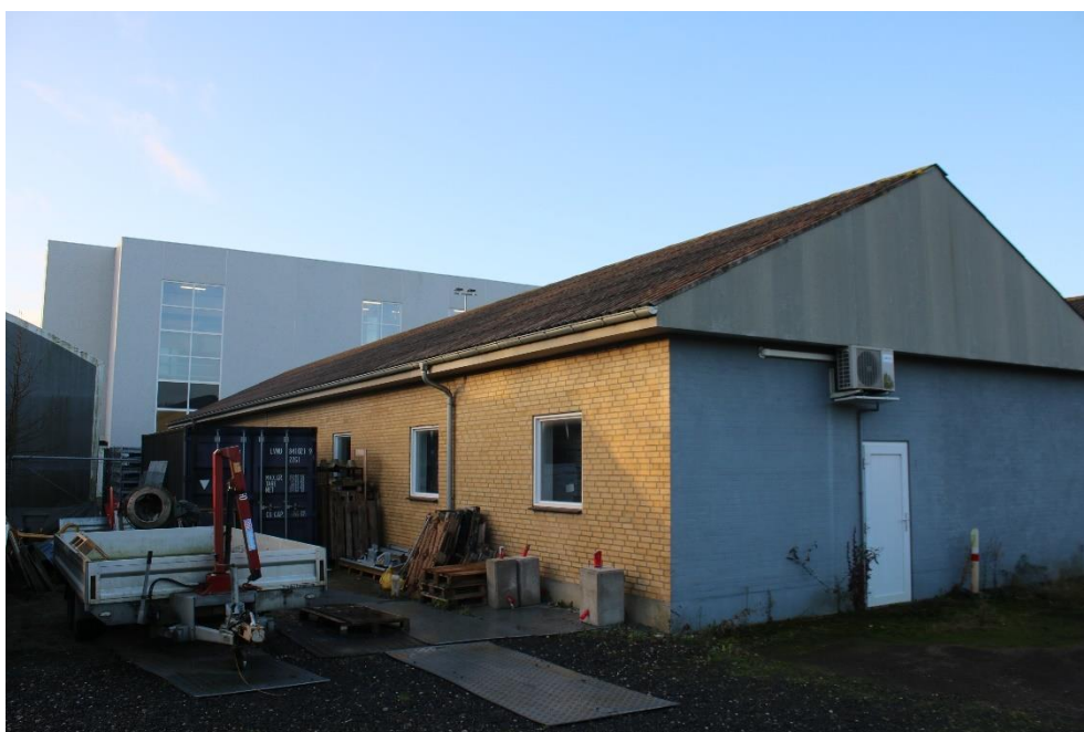
Figur 5-12 Bygning set fra nordøst.
