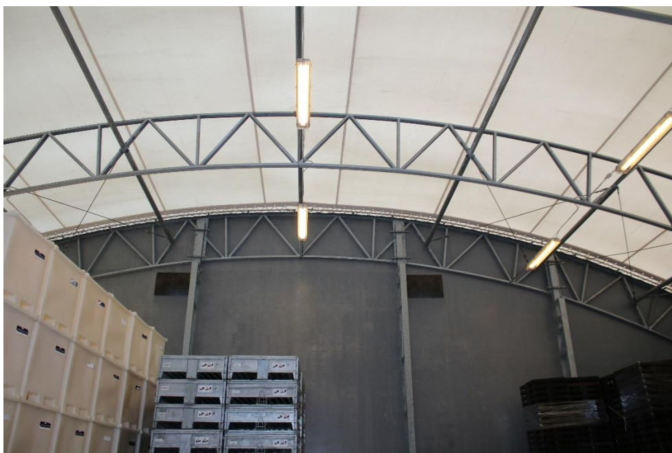
Figur 5-20 Teltlageret består af tykt teltlærred udspændt over et stålskellet. Der er således ingen skjulesteder for flagermus i bygningen.
