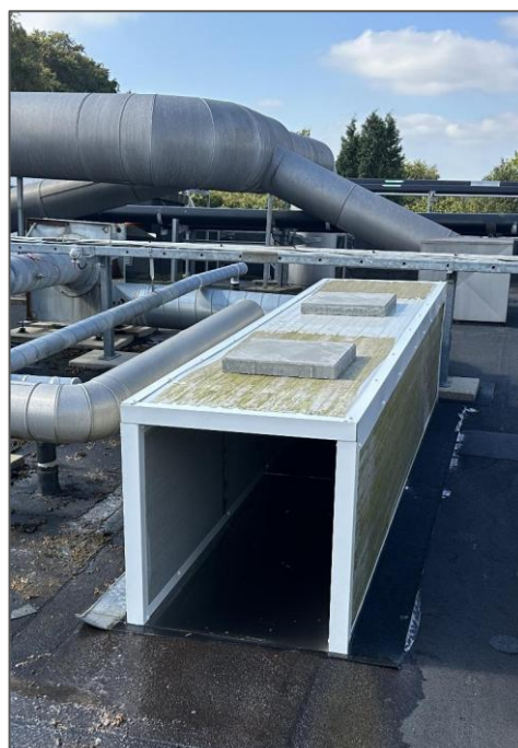
Figur 4 Kilde 7a – Afkast fra vaskelokale. Afkastet er dæmpet yderligere og lagt ned langs med taget, hvor det peger mod øst. Målt 2024-09-19.
