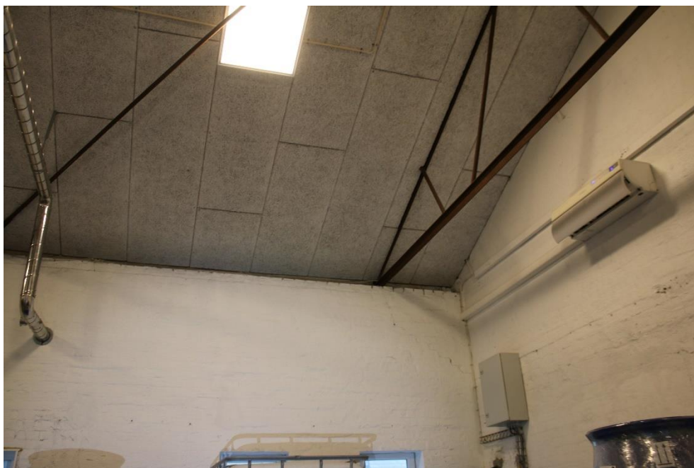
Figur 5-5 Indvendigt loft til kip, hvorfor bygningen er uden loftrum.
