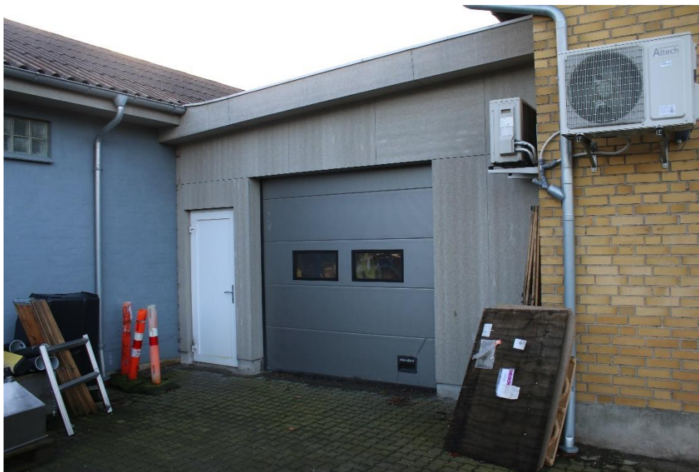
Figur 5-7 Bygning set fra syd.
