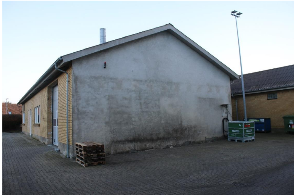
Figur 5-2 Bygning set fra syd.
