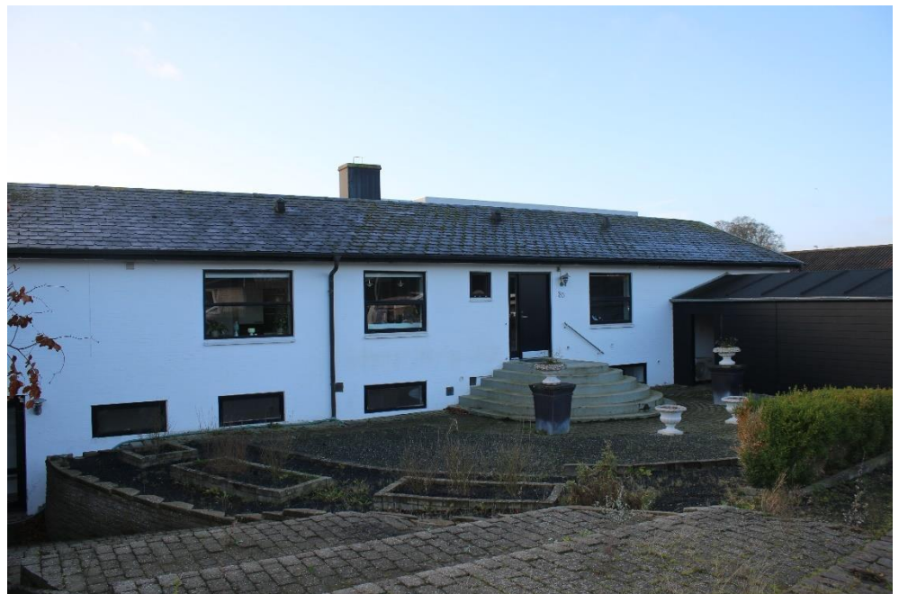
Figur 5-36 Bygning set fra nord.
