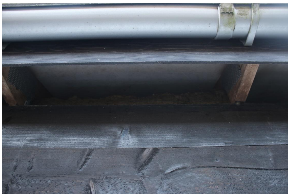
Figur 5-23 Tag med undertag, men uden isolering mod tagplader. Der er åbent ind til tagkonstruktionen, og taget yder ringe beskyttelse imod prædation fra f.eks. mår.
