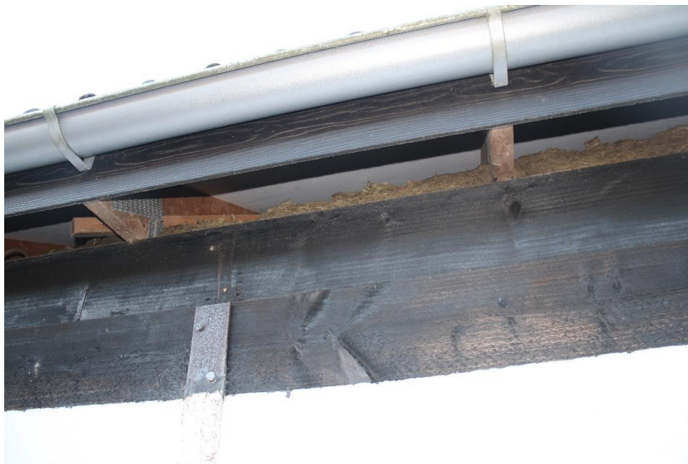
Figur 5-24 Tagudhæng uden underplade og således fri adgang til tagkonstruktion. Der er lagt isolering ud over loftet.
