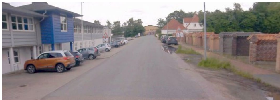
Figur 9-2 Teglværksvej set fra vest mod øst umiddelbart efter krydset ved Teglkrogen. Til venstre ses fabriksområdet og til højre ses området, der planlægges omdannet til parkeringspladser, (COWI, COWI MultiViewer, 2024).
