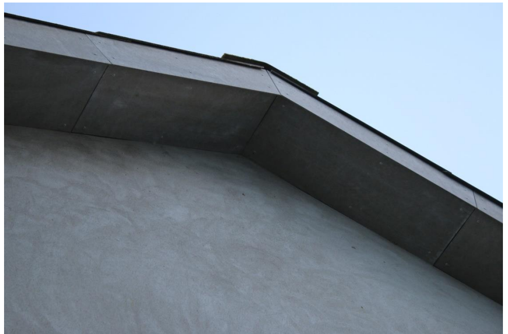
Figur 5-3 Tagudhæng slutter tæt til murværk.
