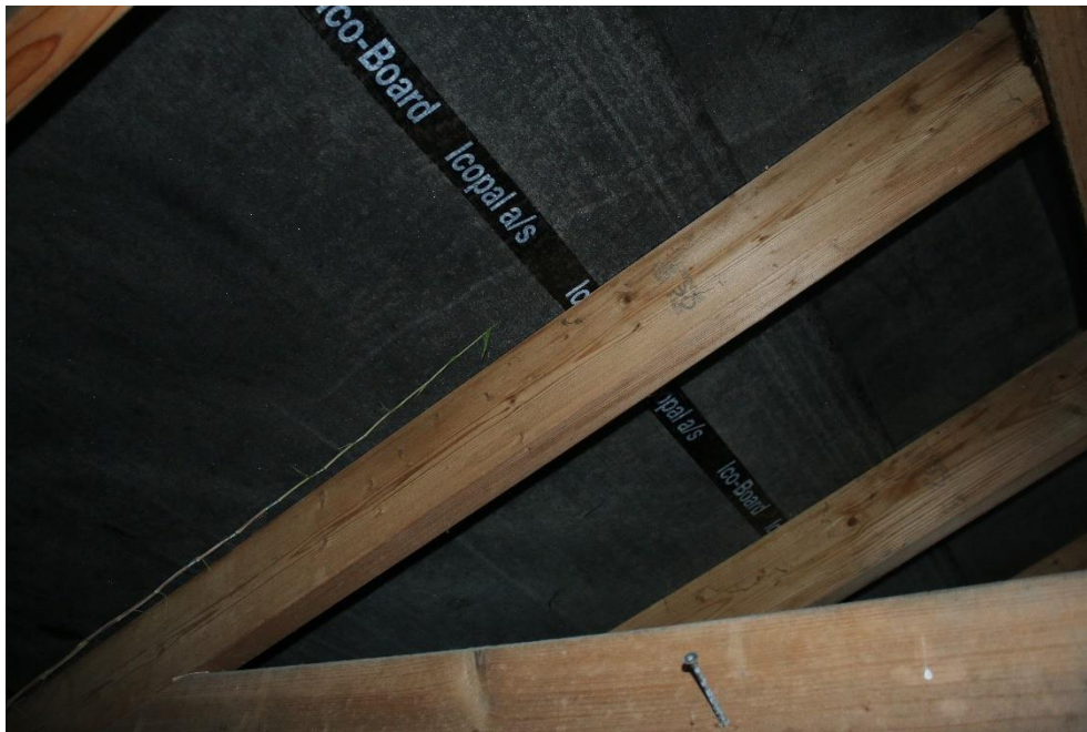
Figur 5-30 Tag med undertag, men uden isolering. Der er dårlige muligheder for skjul for flagermus.
