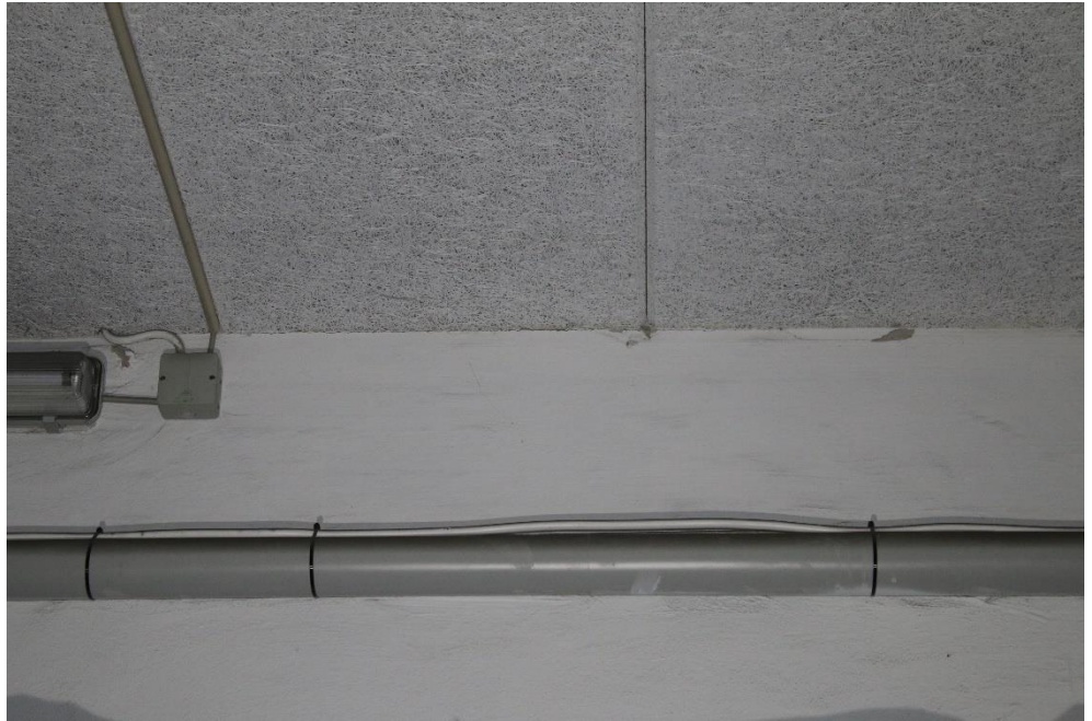
Figur 5-17 Loftsplader slutter indvendigt tæt til murværk.
