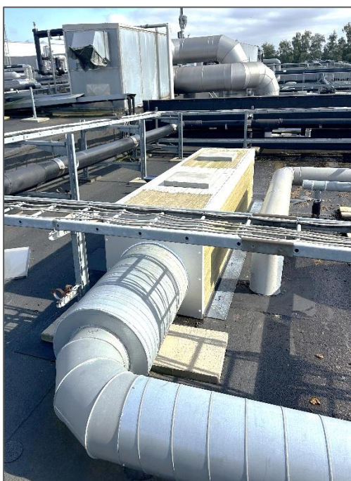
Figur 4 Kilde 7a – Afkast fra vaskelokale. Afkastet er dæmpet yderligere og lagt ned langs med taget, hvor det peger mod øst. Målt 2024-09-19.
