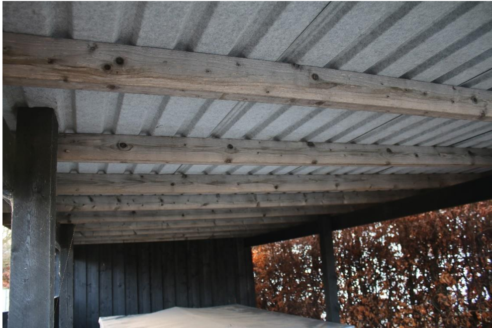
Figur 5-34 Taget består af blikplader uden undertag eller isolering og uden egnede skjulesteder for flagermus.
