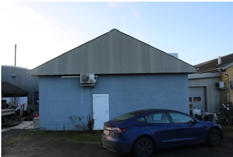
Figur 5-11 Bygning set fra nord.
