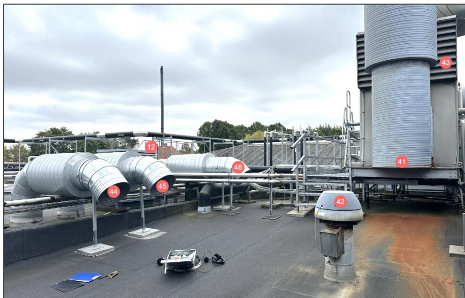
Figur 1 Kilde 12, 44, 45 og 46 (tagventilatorer) er dæmpet med lyddæmpere i 2023. Set fra nordvest. Genmålt 2024-09-19.
