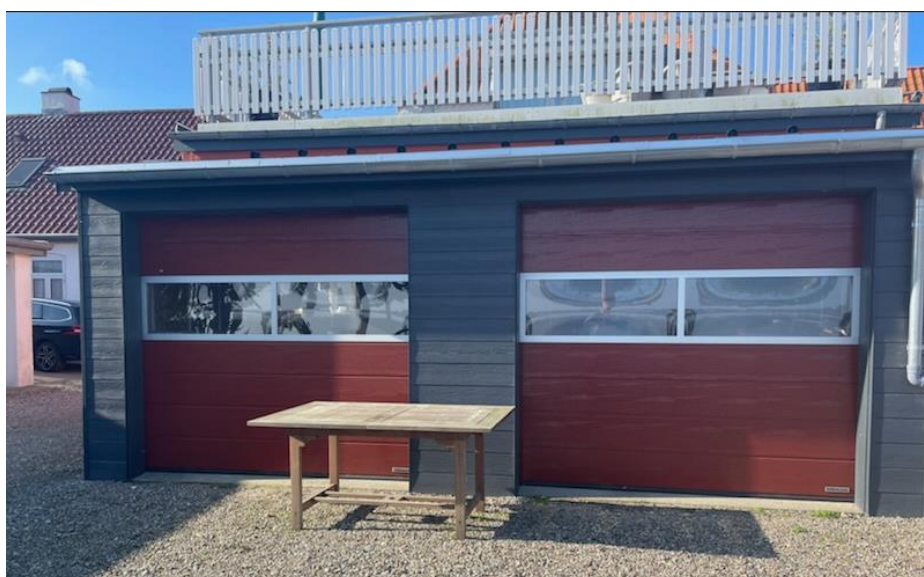
Foto af det opførte udhus.
