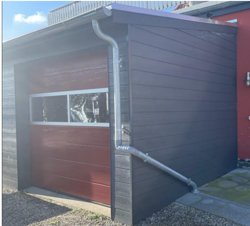
Foto af det opførte udhus set fra siden.
