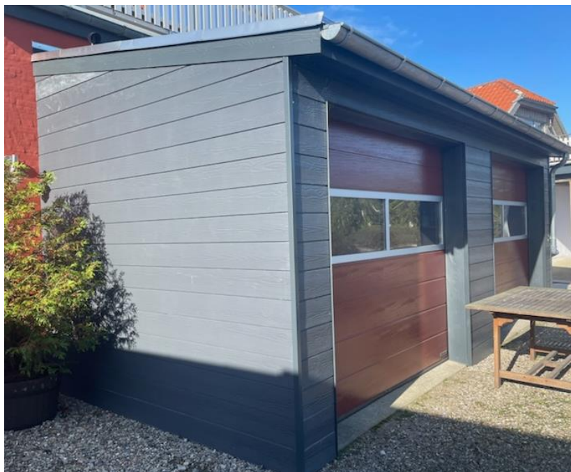
Foto af det opførte udhus set fra siden.
