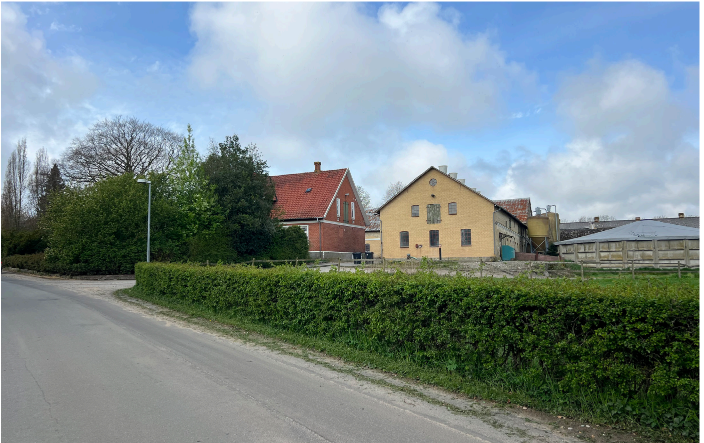
Ejendommen set fra øst.
