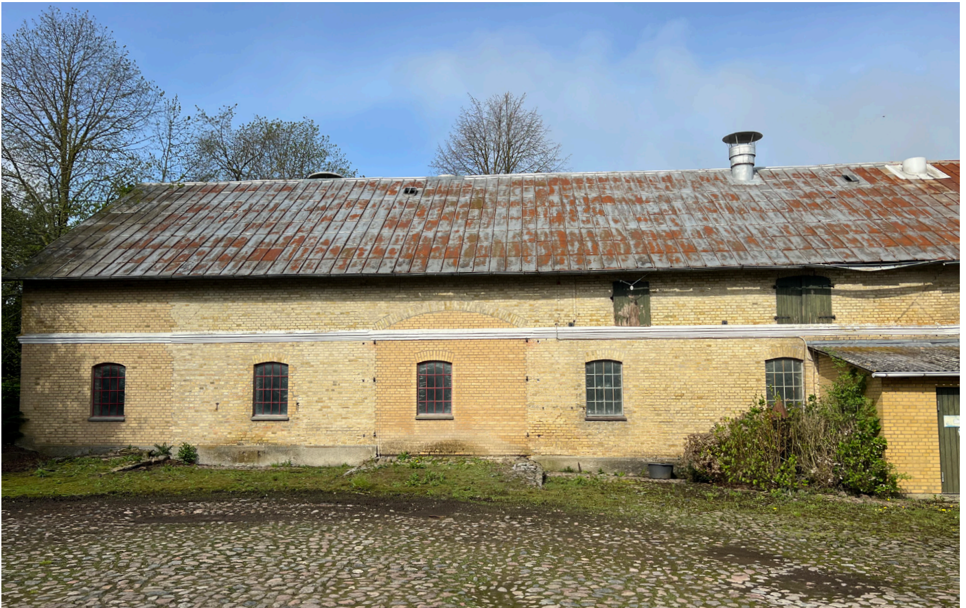
Ejendommen set fra øst.
