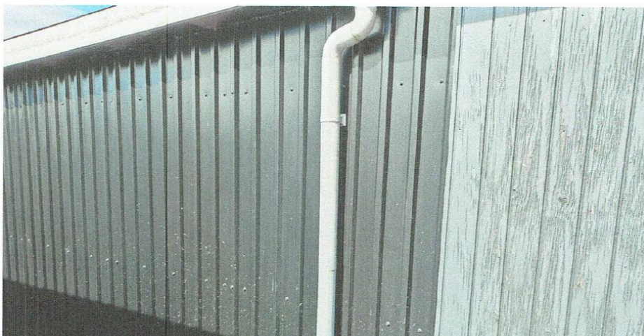
Foto som viser materialer mod nabo – metal på ny overdækning – træ på garage/skur.
