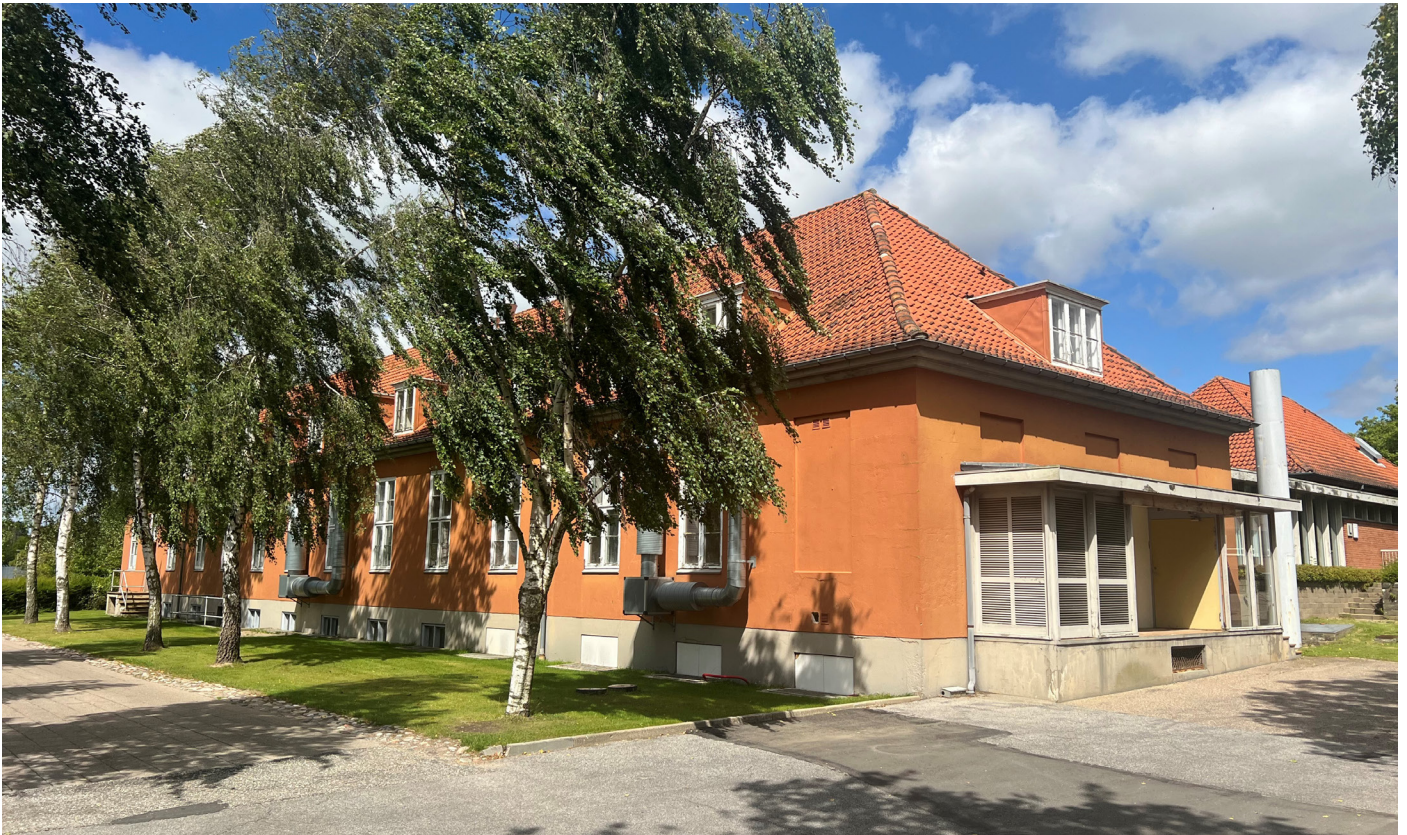
Bygning 10 - sydlig gavl og vest facade.
