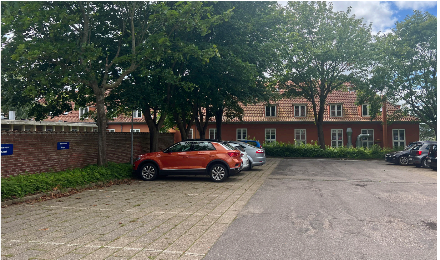
Bygning 10: øst facade.
