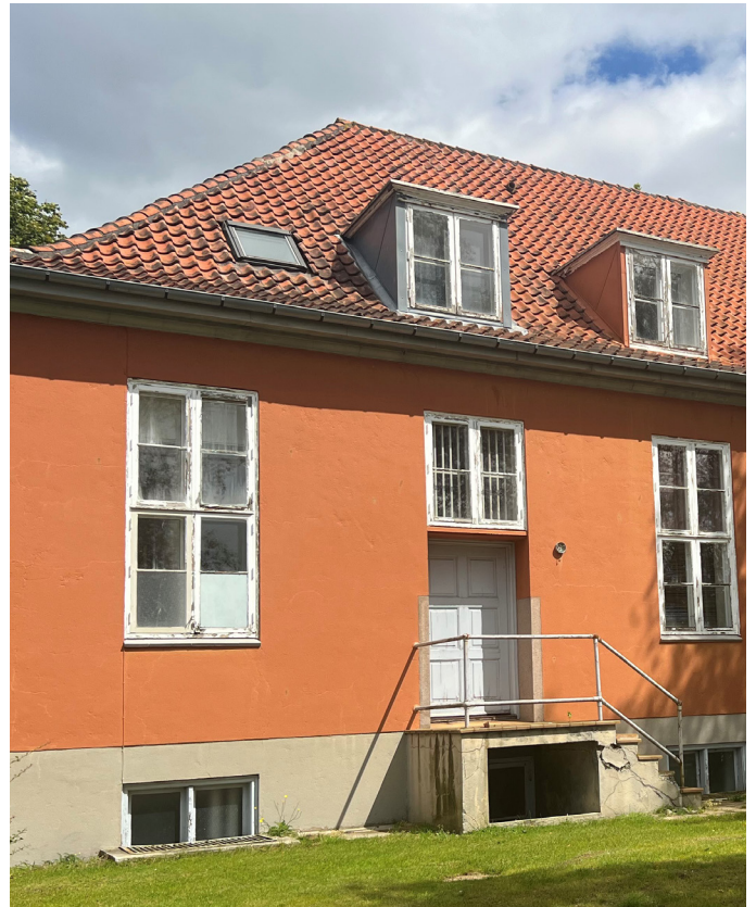
Bygning 10: vest facade.
