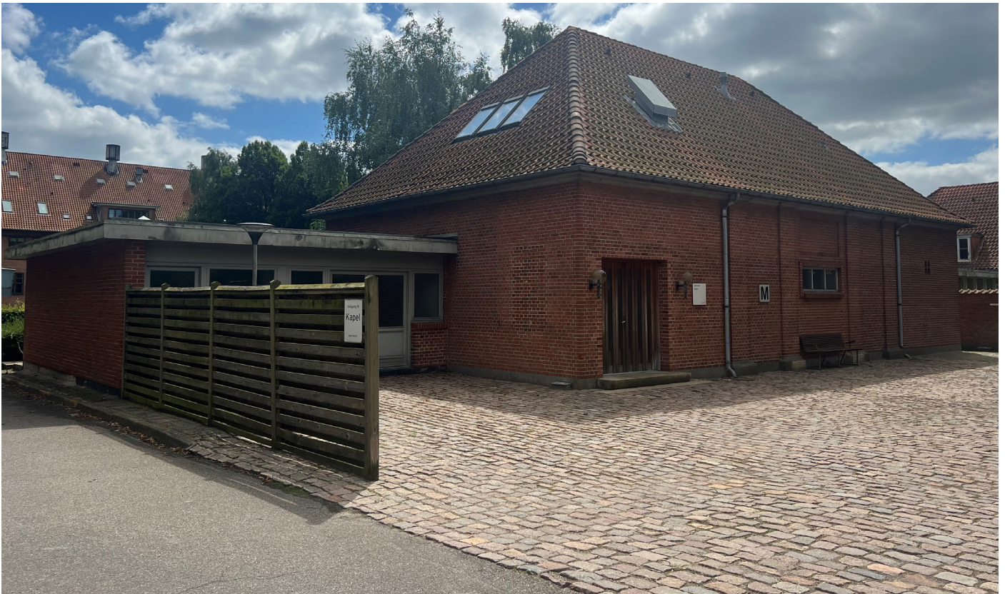
Bygning 14: nordlig facade.
