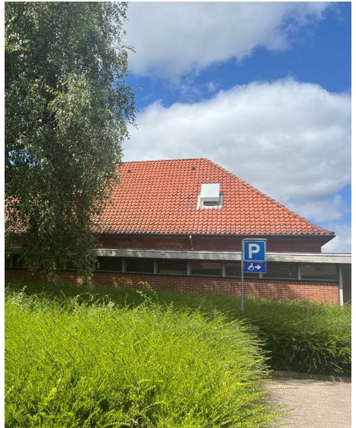
Bygning 14: sydlig facade.
