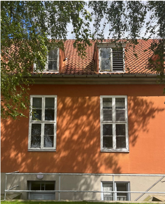
Bygning 10: vest facade.
