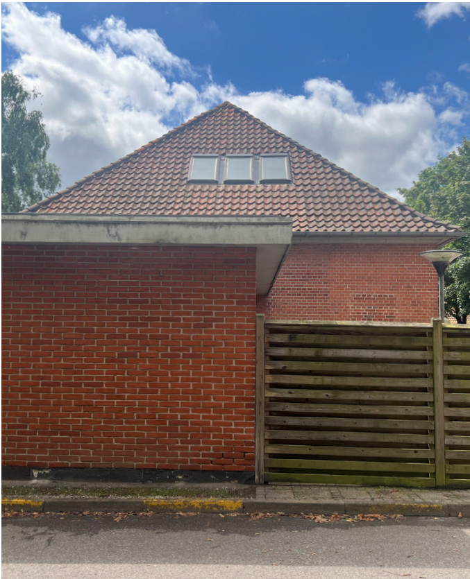
Bygning 14: vest facade.
