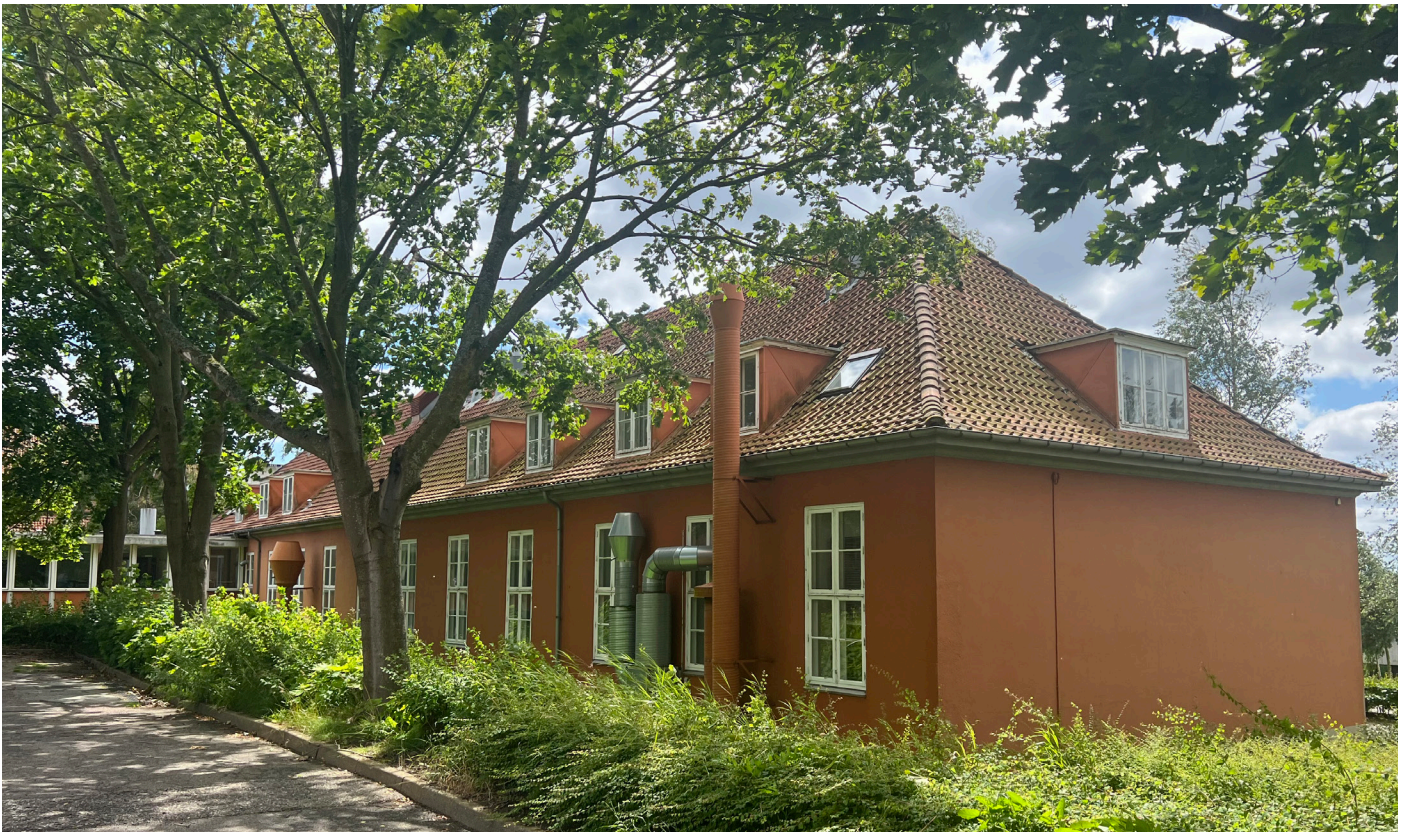
Bygning 10 - nordlig gavl og øst facade.
