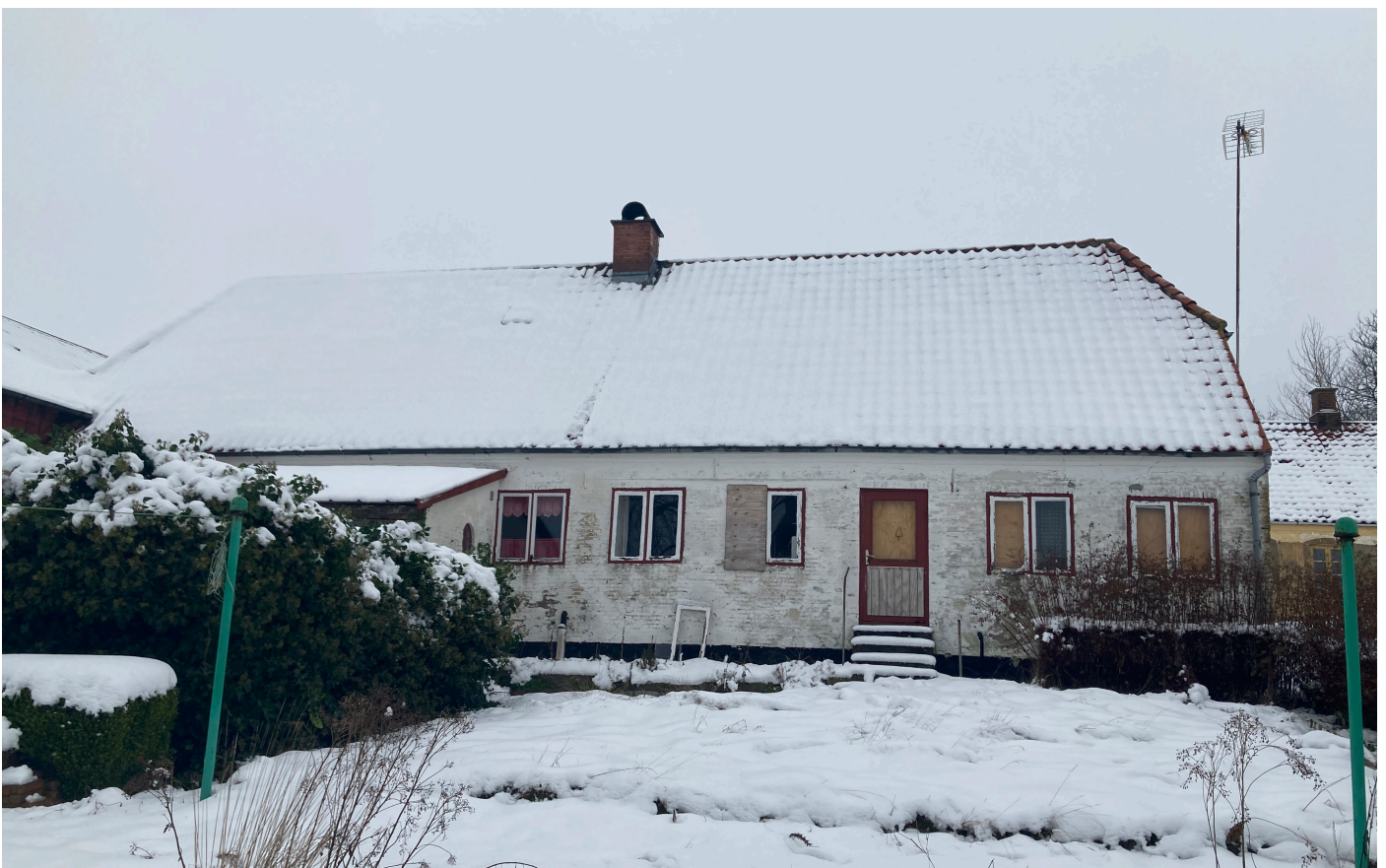
Stuehusets bagfacade set fra havesiden.
