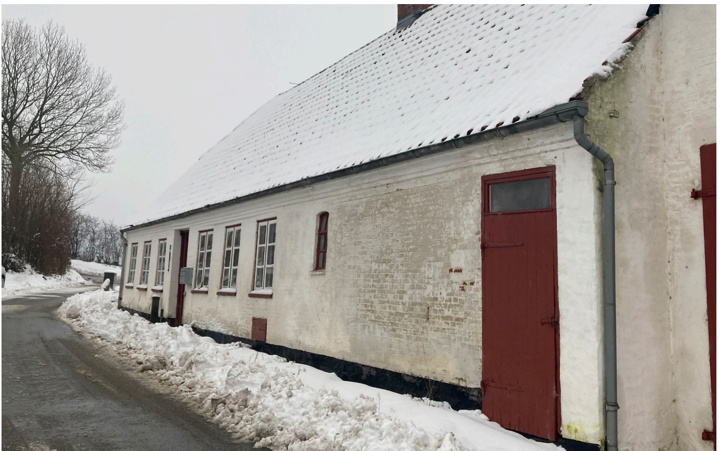
Den nedrivningsanmeldte ejendom set fra Krammarksvej.
