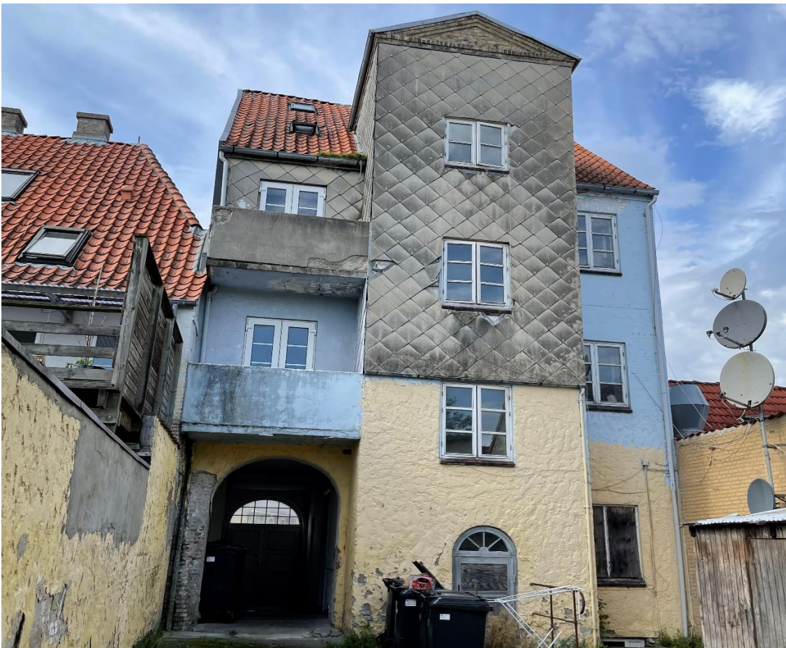
Herover ses bygningens bagfacade. Facaden er delvist pudset og beklædt med eternit.
