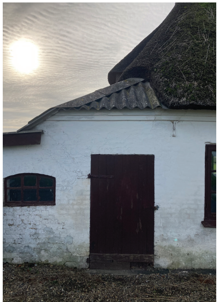
Bygningens bagfacade set fra sydvest. Det fremgår, at der på et tidspunkt er lavet skalmur, hvorved den originale bindingsværksfacade er skjult.
