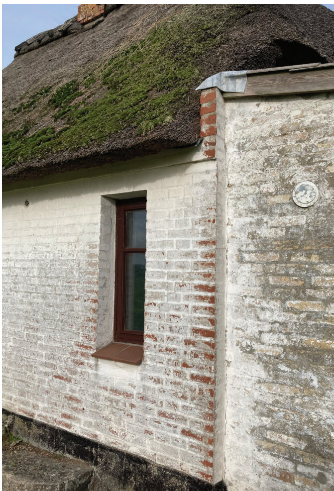
Bygningens bagfacade set fra sydvest. Det fremgår, at der på et tidspunkt er lavet skalmur, hvorved den originale bindingsværksfacade er skjult.
