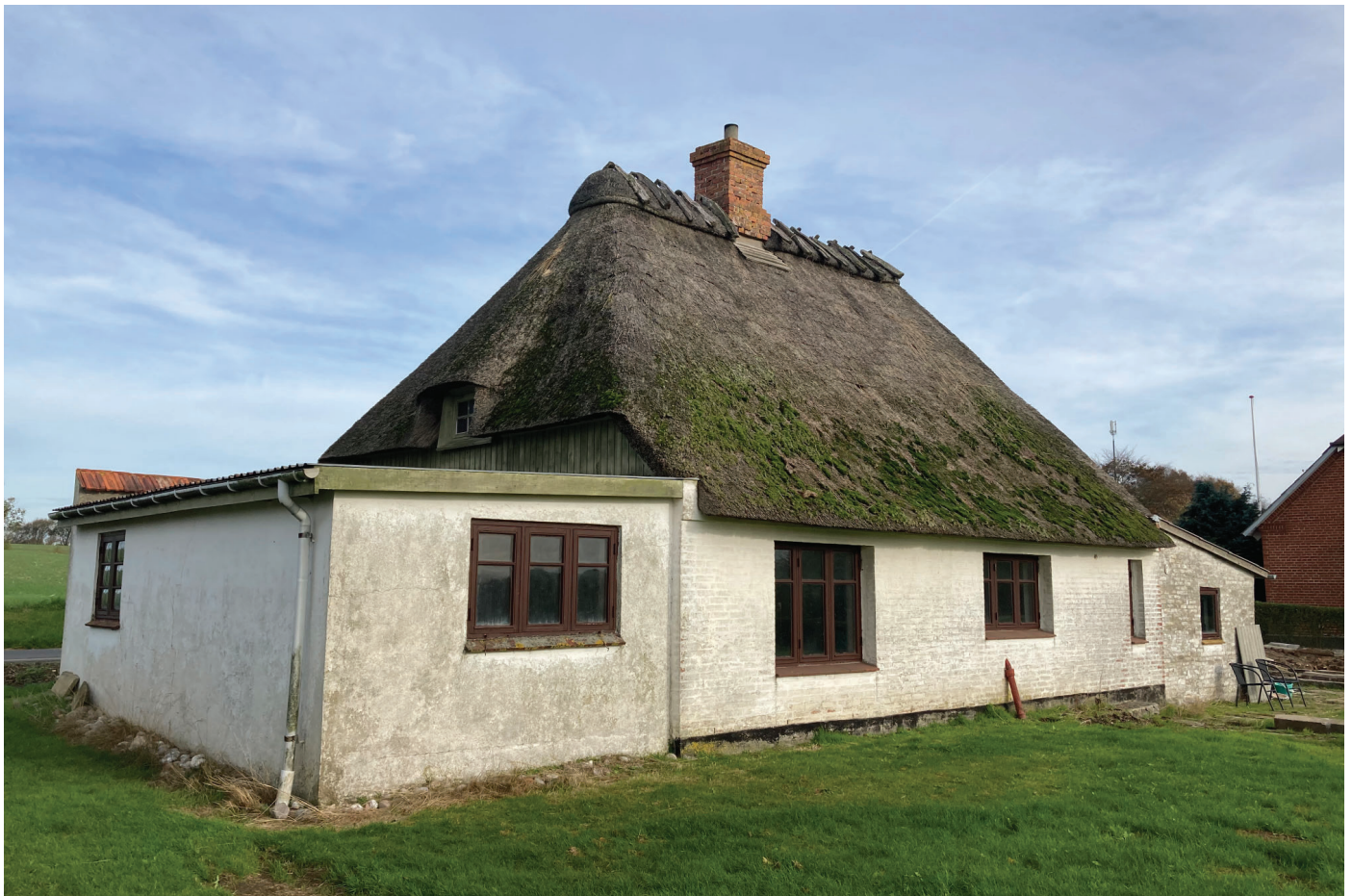
Bygningens bagfacade set fra sydvest. Det fremgår, at der på et tidspunkt er lavet skalmur, hvorved den originale bindingsværksfacade er skjult.
