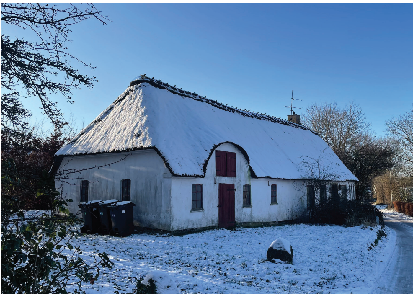
Herover ses ejendommen fra nordsiden på Storemarksvej (december 2022).
