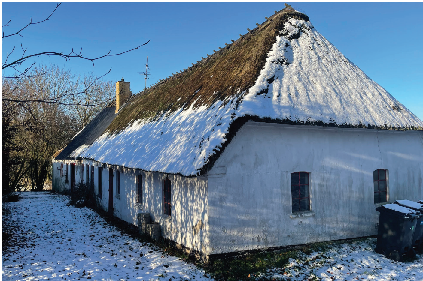
Sydfacaden set fra sydøst.
